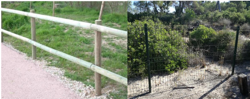
Figuras 5 & 6. Aspecto de las vallas de madera y metálica descritas. (Fuente: Imagen Izquierda. Catálogo Fitor Forestal / Imagen Derecha. Lugar: Playa de El Saler; Fotografía: Juan Miguel Giner Valero)
