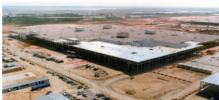
Ilustración 1 Construcción de la Planta Ford, Almussafes
