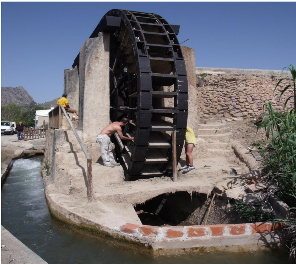
Fig.3. Reparaciones en la rueda de corriente baja “Noria Hoya de D. García”.(14/04/2014)
