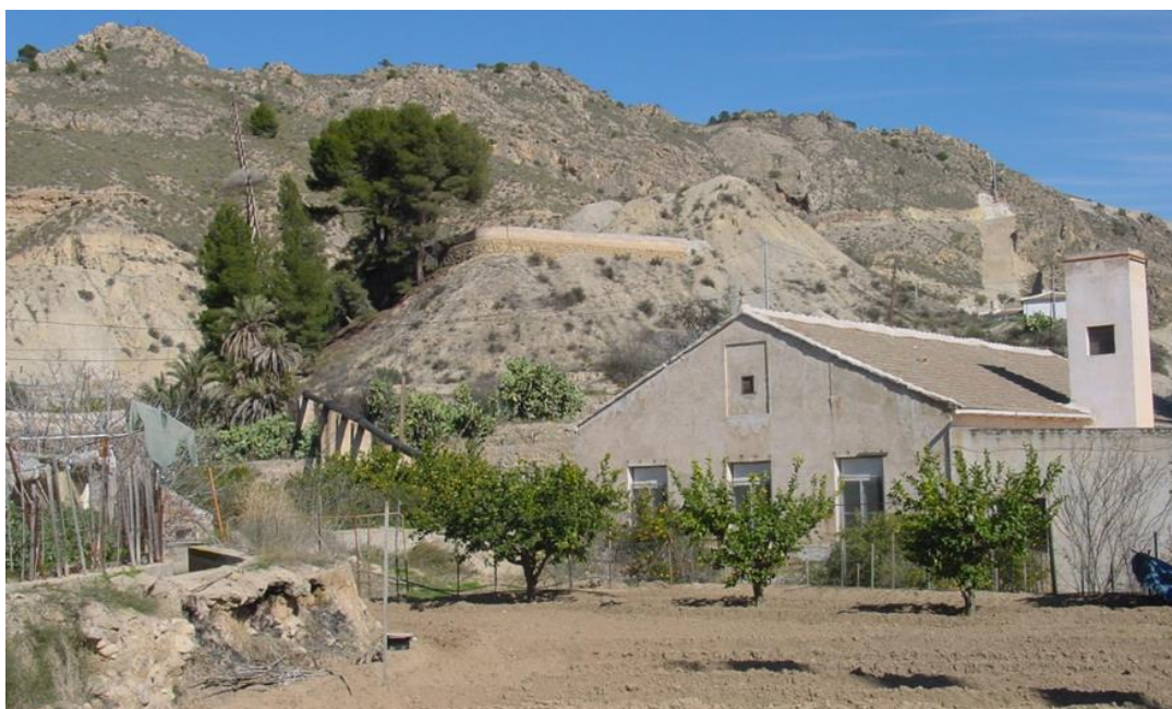
Fig.8. Elevación de aguas del Motor Resurrección. (200 l/seg a 135,4 metros de altura desde 1927 de forma continuada). (16/02/2005).
