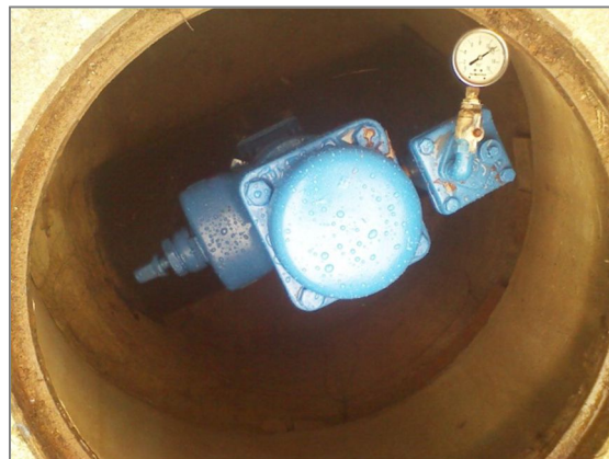
Figura 3.4.5-3. Manómetro de ventosa 3.1
