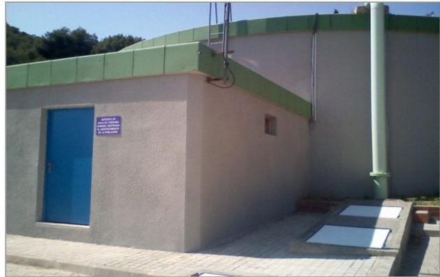
Figura3.3.4-1. Depósito Los Valles.
