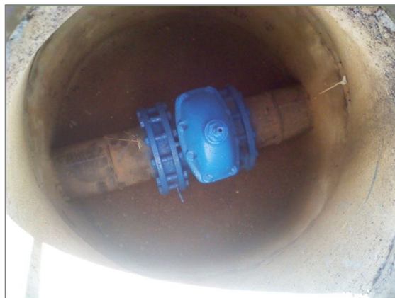
Figura 3.2.1-2. Válvula de corte Fase 3.
