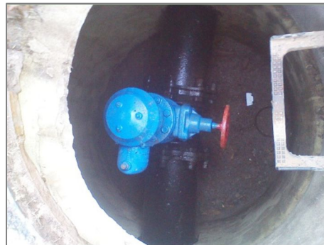
Figura 3.4.2-2. Ventosa 1.3. Conducción Benifairó/Faura
