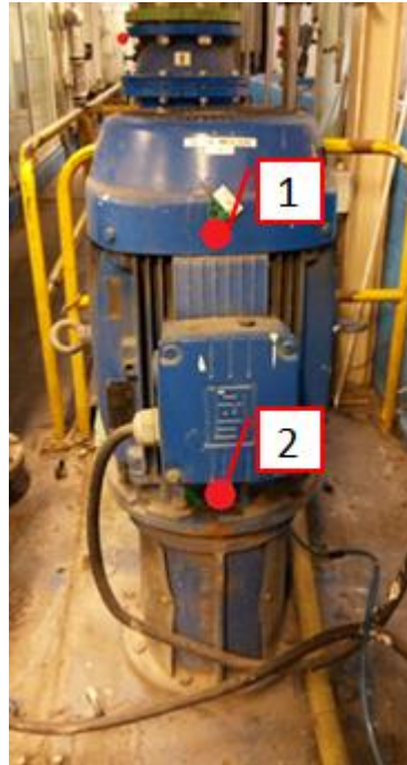
Figura 36. Ubicación acelerómetros.
