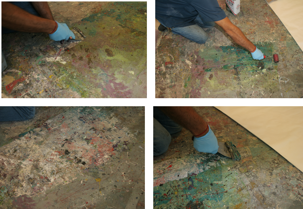
Figure 4 – Proceso de raspar la superficie y de retirar las capas de pintura.
