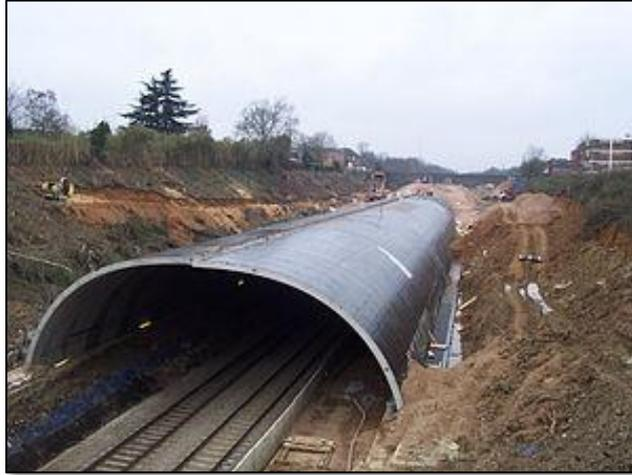
Fig.45. Ejemplo método "Cut and Cover" (falso túnel). Fuente: Wikipedia.org.
