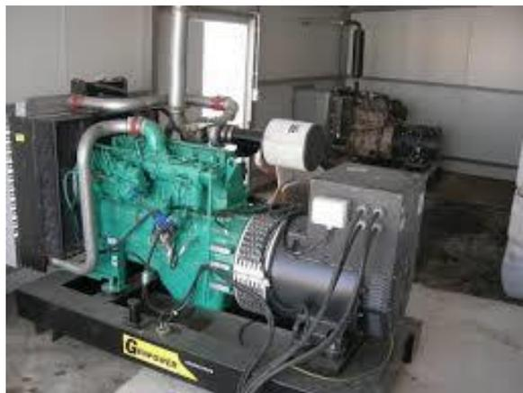
*Ilustración 8. Ejemplo de grupo electrógeno convencional.*
