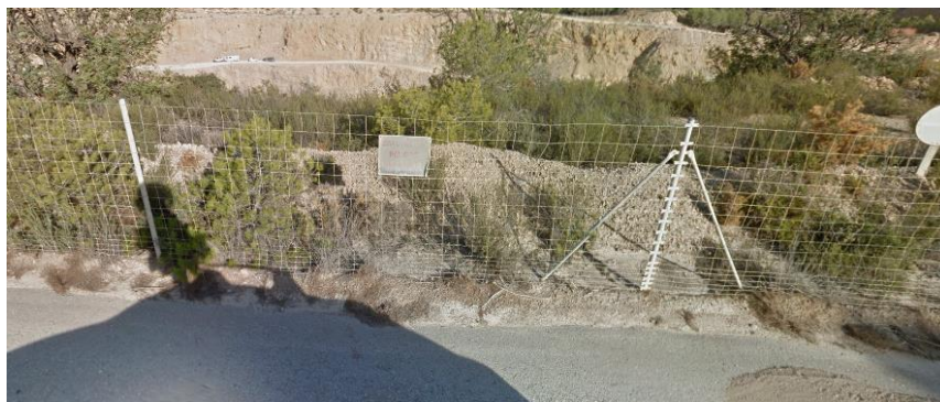
Imagen 19. Detalle de la alambrada perimetral sobre la ladera sur. Fuente Google Maps.
