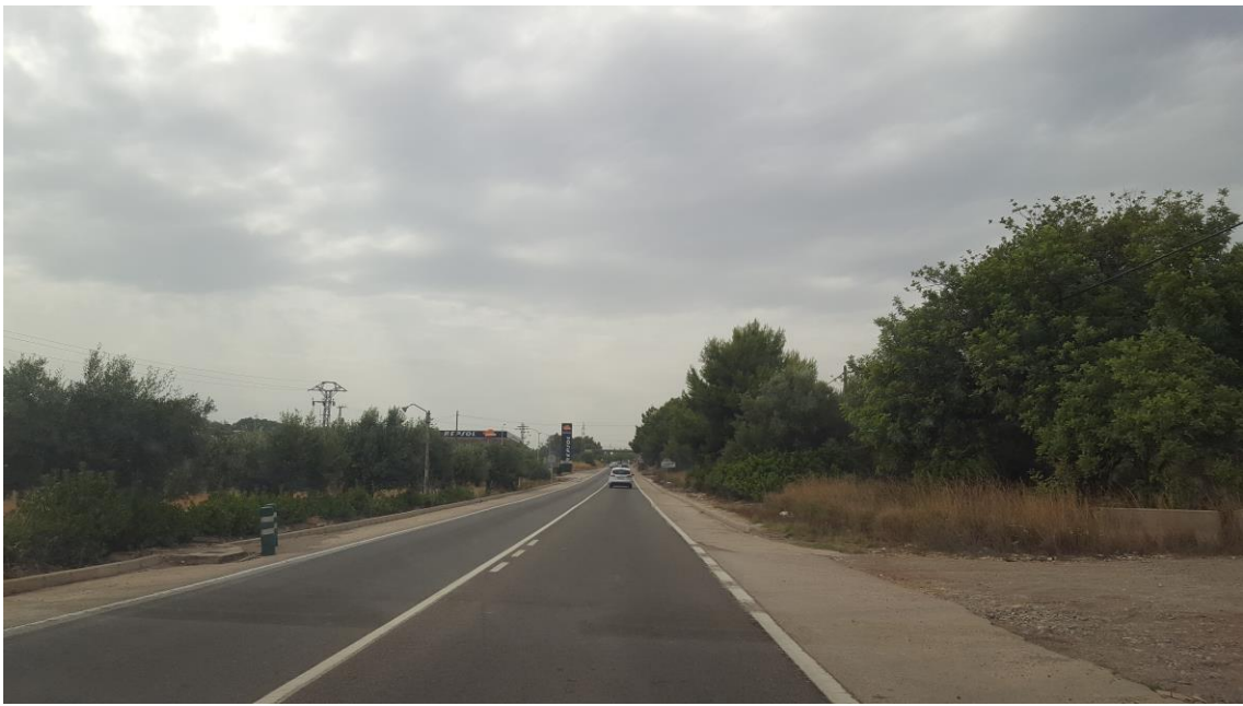
Imagen 3. Detalle de la CV-37 a la altura de la Presa (Manises). Fuente propia
