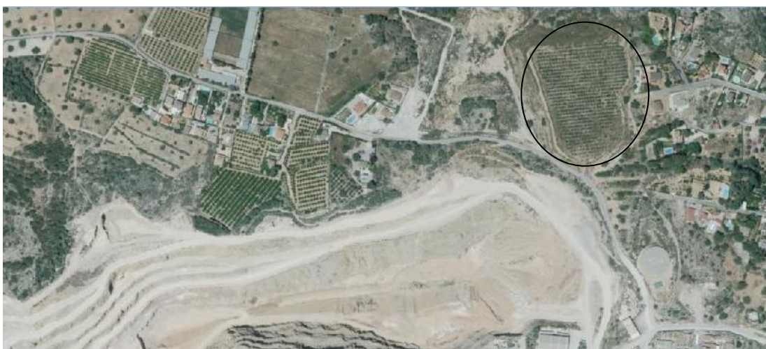
Imagen 3. Detalle del vaso de vertido y de fase anterior ya restaurada. Fuente Terrasit
