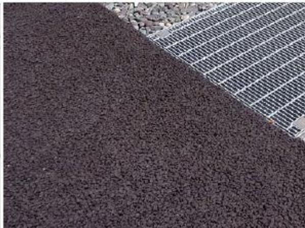
Ilustración 36. Detalle de hormigón poroso
