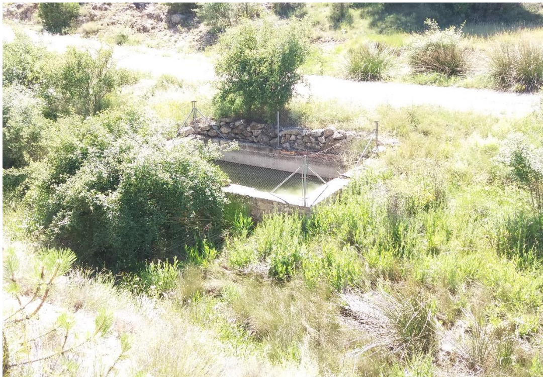
Fotografía del depósito El Cabezo.
