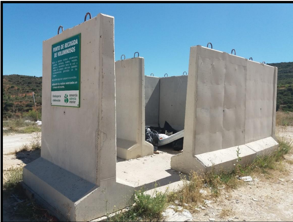
Foto 24: Punto limpio de Castielfabib.
