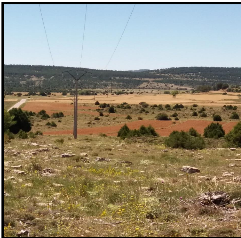
Foto 14: Red eléctrica por el municipio de Castielfabib.
