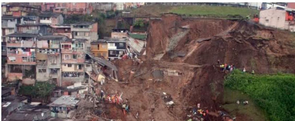
Imagen 3.7 - Deslizamiento en el barrio Cervantes, en Manizales, Colombia. Fuente: (“Manizales llora por el barrio Cervantes,” 2011)
