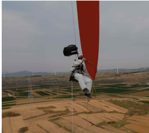
Figura 5: Descenso en cuerda alrededor de la pala
