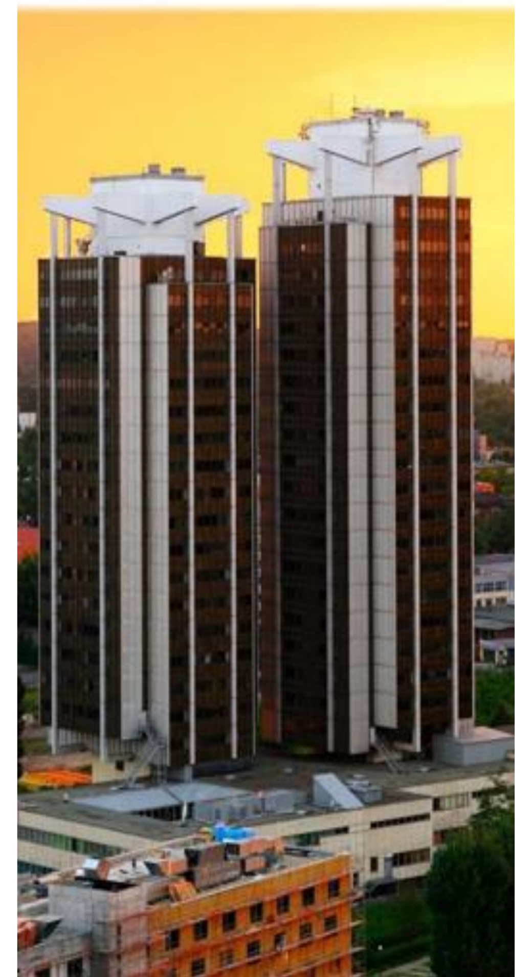
Stalexport Towers. (Katowice, Poland)
