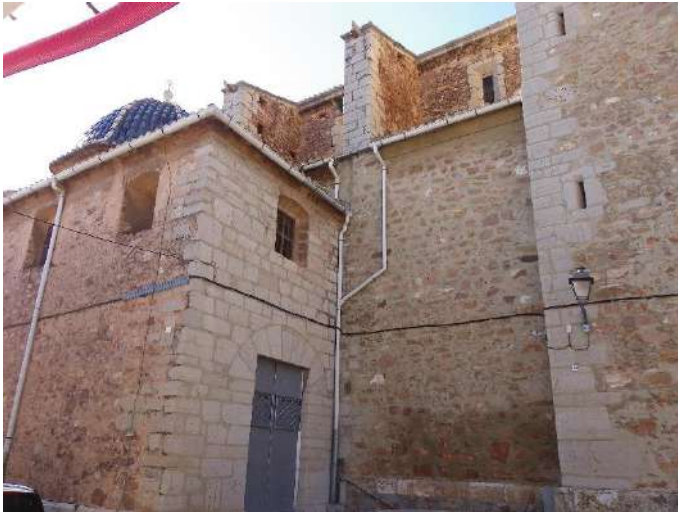
Figura 76. Imagen de los sistemas de evacuación mediante canalones. Imagen propia 20/08/17
