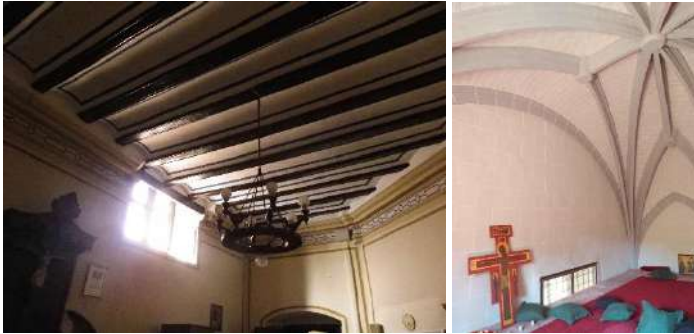
Figuras 78 y 79. Imagen del forjado instalado con posterioridad. Imagen propia 24/08/17
