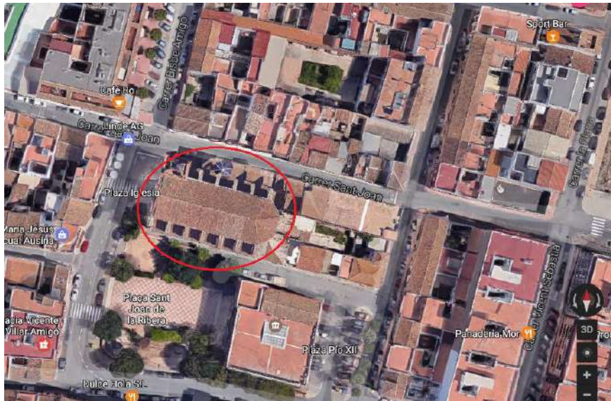
Figura 3. Localización de la iglesia. Google Earth 6/02/17.
