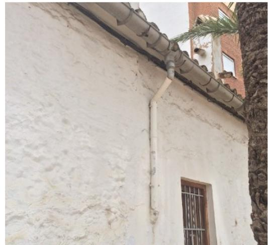
Fig. 5.16 Canalón visto
