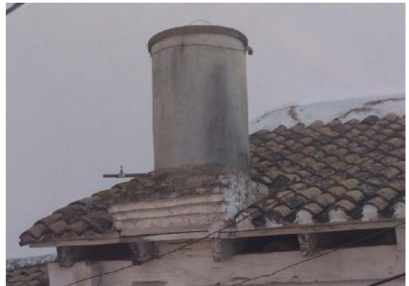
Fig. 5.22 Depósito de agua de fibrocemento
