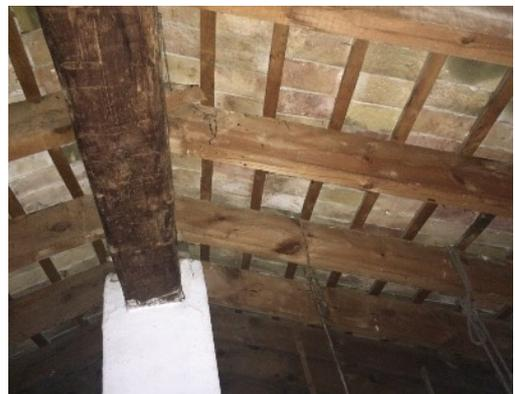
Fig. 5.9 Cubierta tipo 1 sin cañizo
