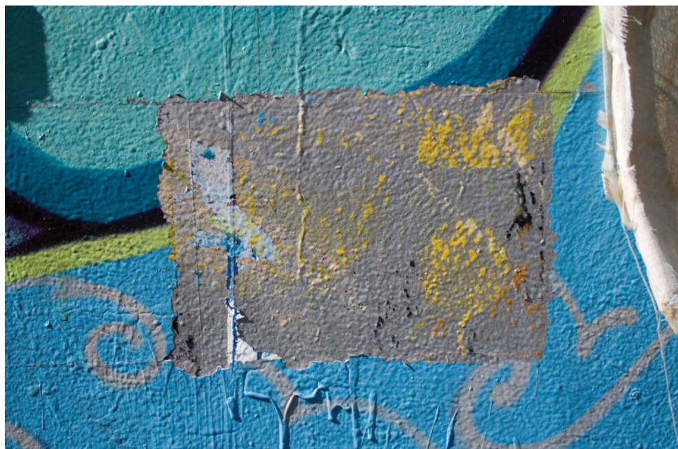
Figura 66. Experimentación práctica inicial, muro tras arranque.
