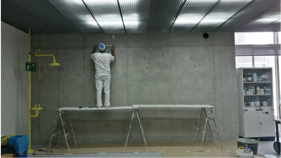
Figura 68. Delimitación y preparación del soporte mural.
