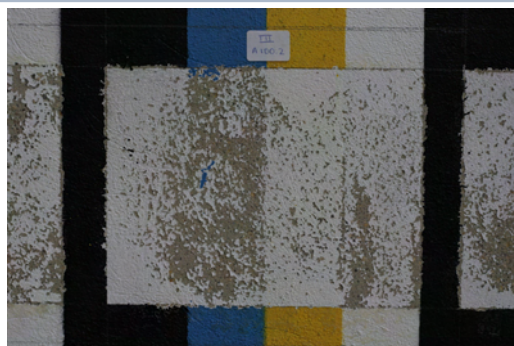
Muro tras arranque
