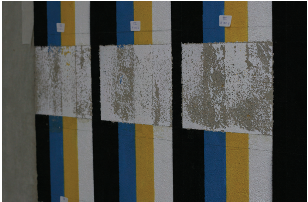
Figura 80. Superficie del muro tras arranque.
