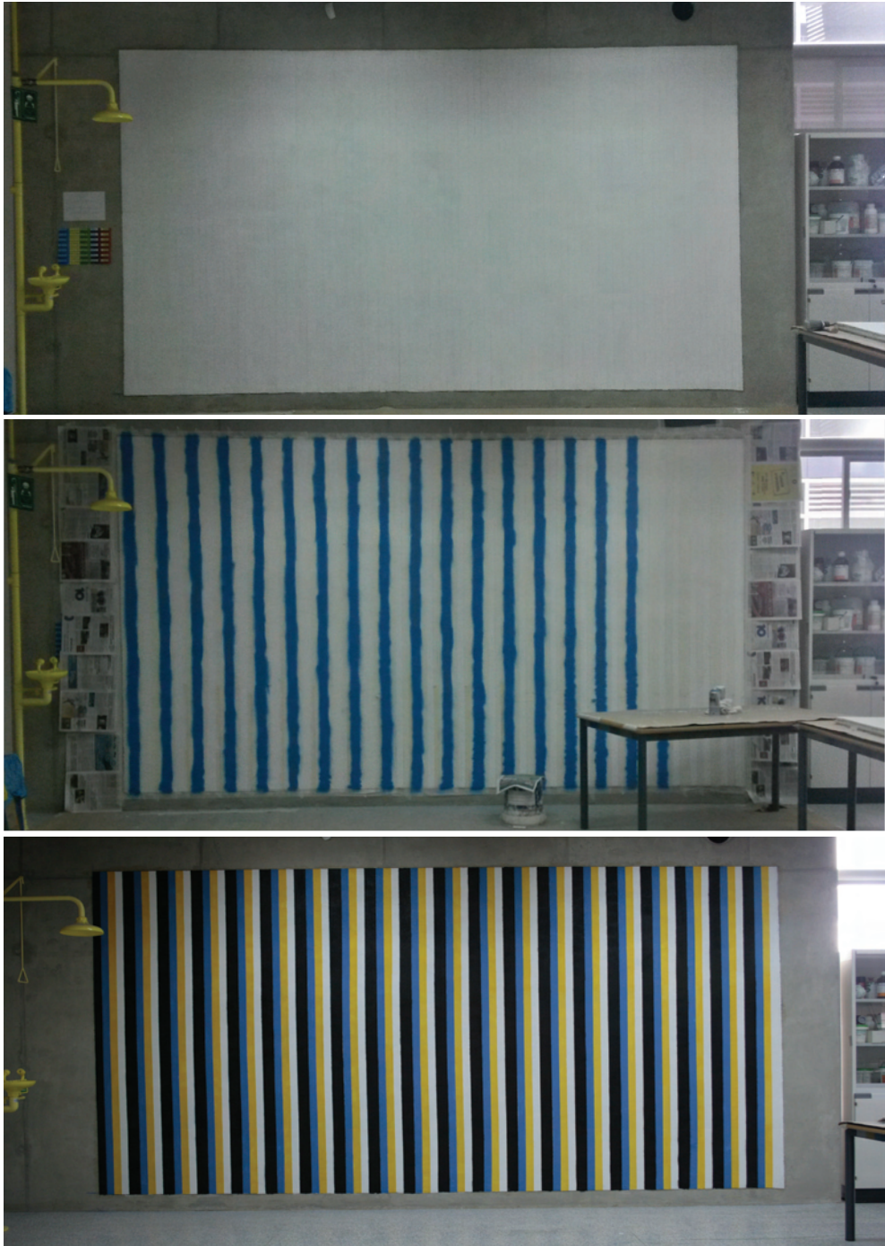
Figura 74. Colocación de reservas y pintado de color Blanco R-9010; Figura 75. Pintado de Azul Europa RV-152; Figura 76. Mural finalizado.
