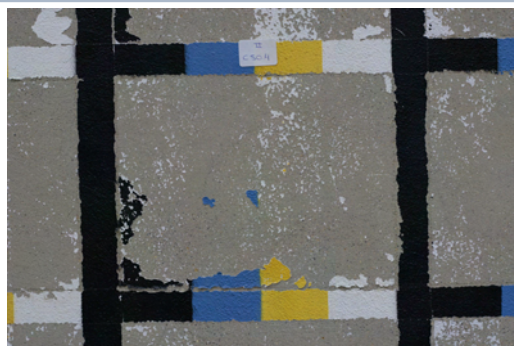
Muro tras arranque
