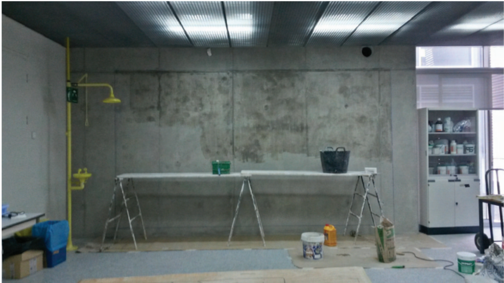
Figura 69. Preparación del soporte: aplicación de resina acrílica.
