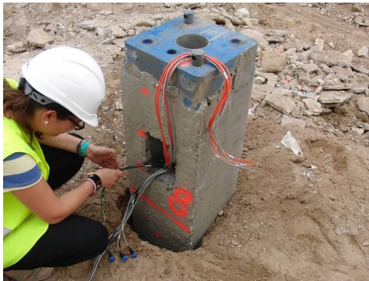
Figura IV-37: Apertura del cajetín inferior del pilote y extracción del cableado de espera procedente del tramo inferior.
