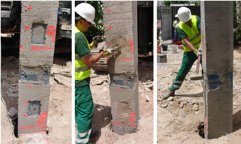
Figura IV-41: Izda. y centro. Los cajetines de las juntas donde se alojan todas las conexiones se cierran y se protegen con mortero de cemento. A la dcha. colocación de los pasadores de unión
