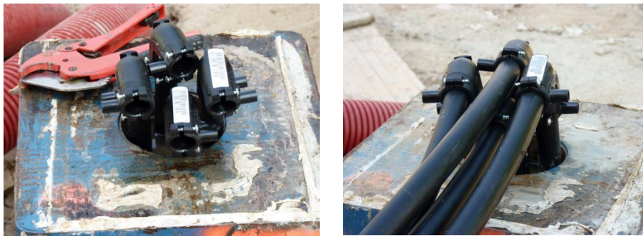
Figura IV-56: Conexión mediante codos a la tubería horizontal
