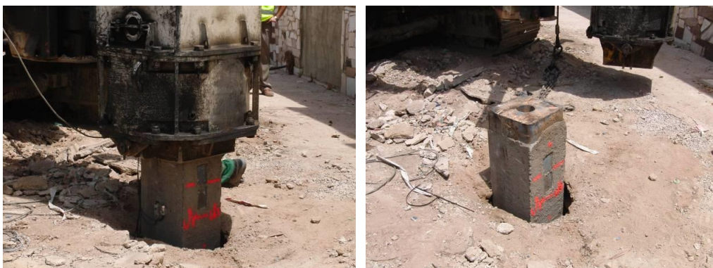
Figura IV-42: Finalización de la hinca
