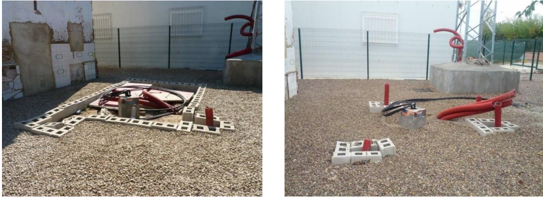
Figura IV-65: Encachado de grava sobre geotextil
