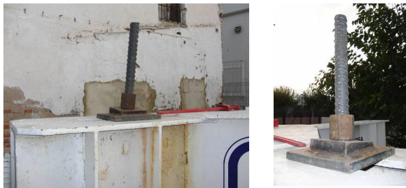
Figura IV-71: "Rabillo" de barras sobre bastidor. Tuerca, contratuerca y placa
