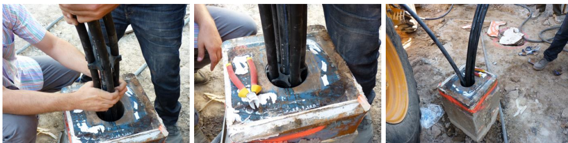
Figura IV-55: Introducción de la sonda en el interior del pilote
