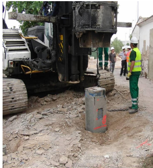
Figura IV-34: Presentación y nivelado
