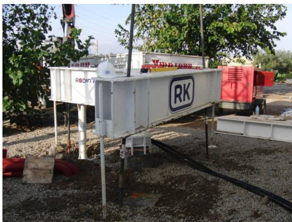
Figura IV-68: Instalación del bastidor
