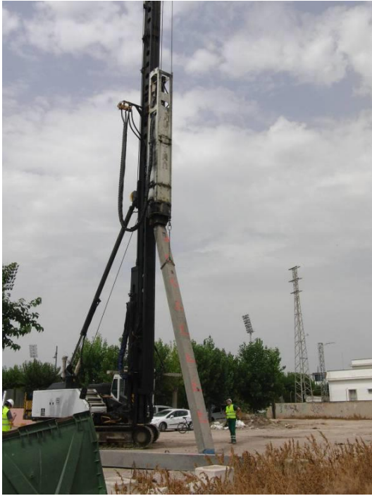
Figura IV-33: Izado del pilote,
