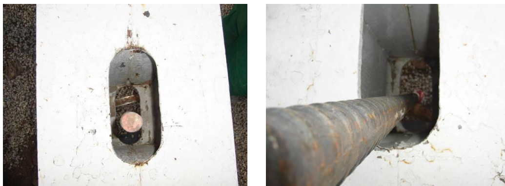
Figura IV-69: Centrado del bastidor sobre las barras
