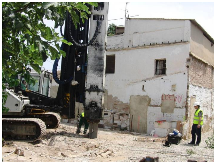
Figura IV-47: Realización del ensayo de carga dinámica (P.D.A.)
