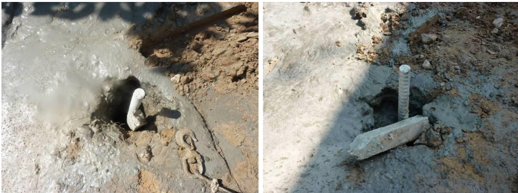
Figura IV-64: Anclajes finalizados. Introducción de la barra y centrado de la misma en la perforación
