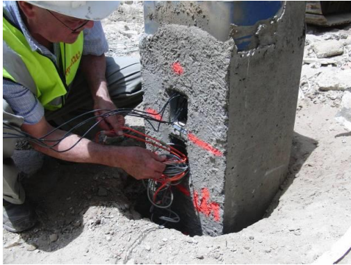
Figura IV-43: Apertura de los cajetines superiores y extracción del cableado
