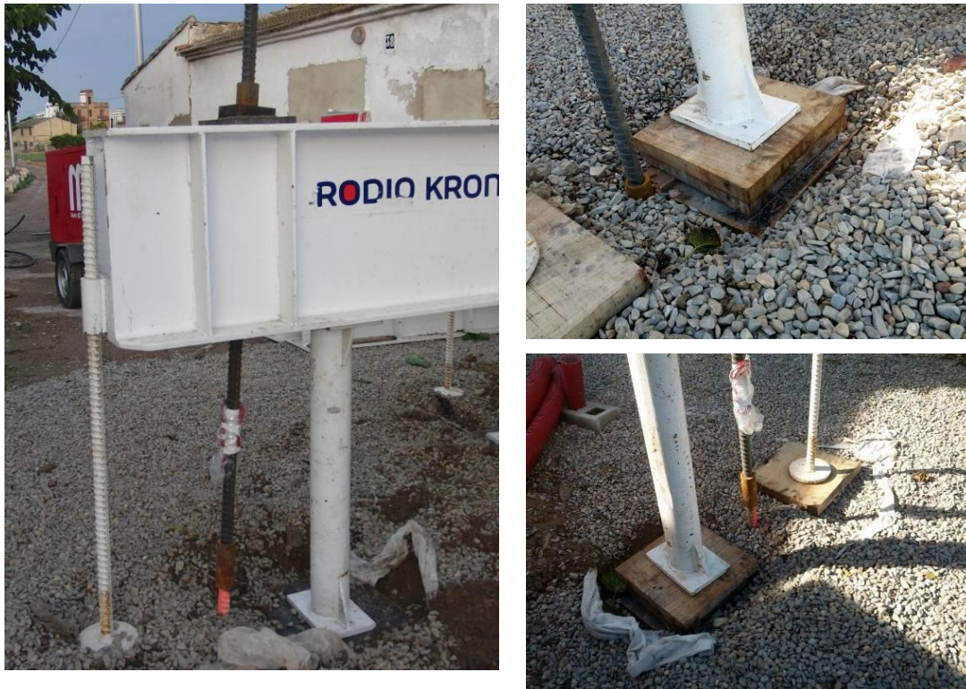
Figura IV-70: Nivelación del bastidor. Colocación de las patas y placas de reparto
