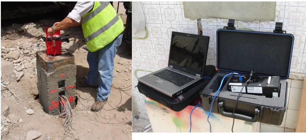
Figura IV-44: Izda. Comprobación de la instrumentación tradicional. Dcha. Interrogador y PC para comprobación de la fibra óptica
