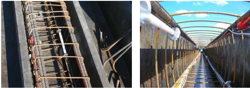
Figura IV-28. Instrumentación dispuesta en el pilote
