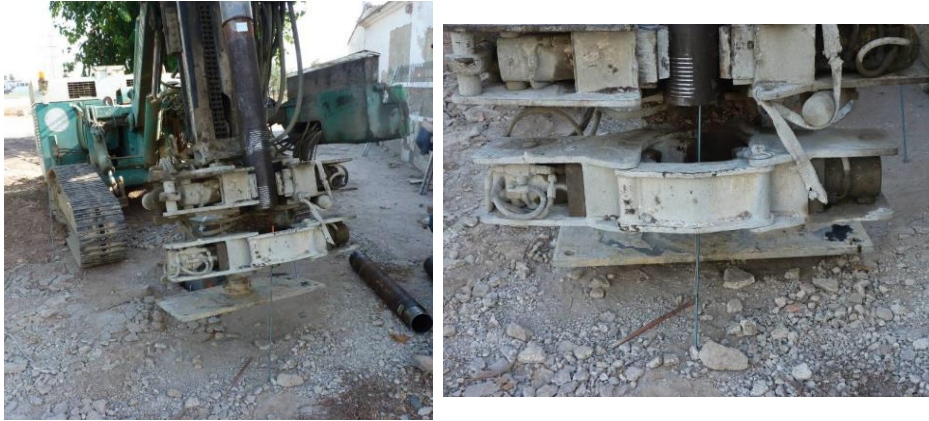
Figura IV-63: Inicio de los trabajos de perforación
