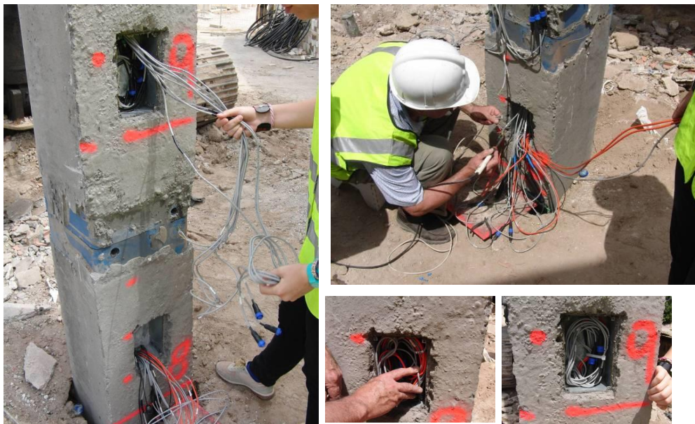
Figura IV-40: Apertura del cajetín superior y realización de las conexiones
