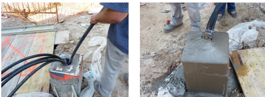
Figura IV-58: Inyección del mortero en el interior del pilote
