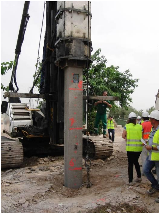
Figura IV-35: Proceso de hinca
