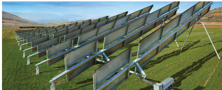
Ilustración 8. Seguidor de eje polar. Fuente: mecasolar.com.
