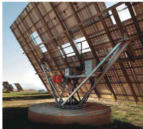
Ilustración 10. Seguidor de 2 ejes. Fuente: mecasolar.com.
