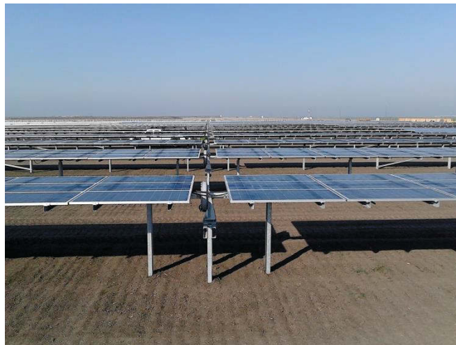
Ilustración 7. Seguidor de eje horizontal. Fuente: mecasolar.com.
