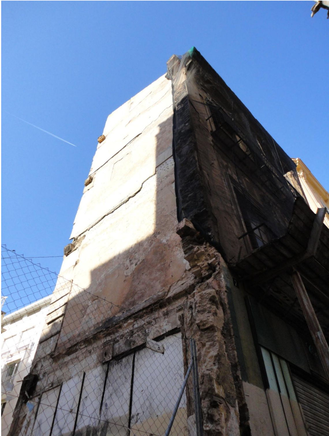
Imágenes 4 y 5. Casa del Relojero en la parte posterior y lateral, antes de las obras de rehabilitación. Fuente: Francisca Ramón Fernández.
