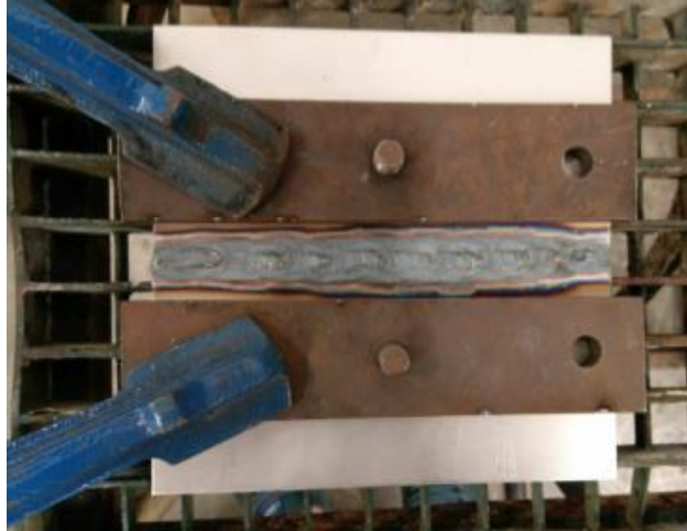
Ilustración 8. Amarrado de piezas previo a la soldadura
