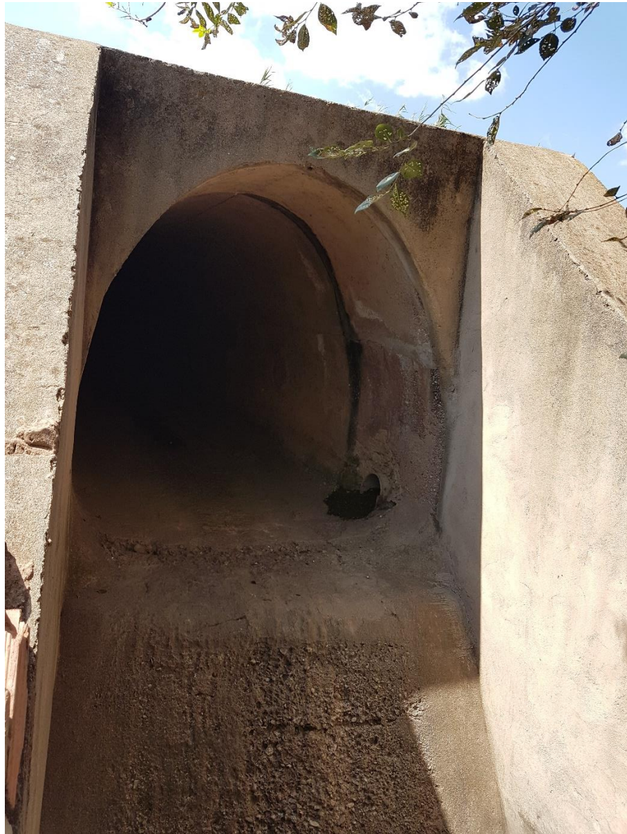
Ilustración 10" Foto detalle de la desembocadura del colector de pluviales al barranco del Carraixet. Fuente propia"
