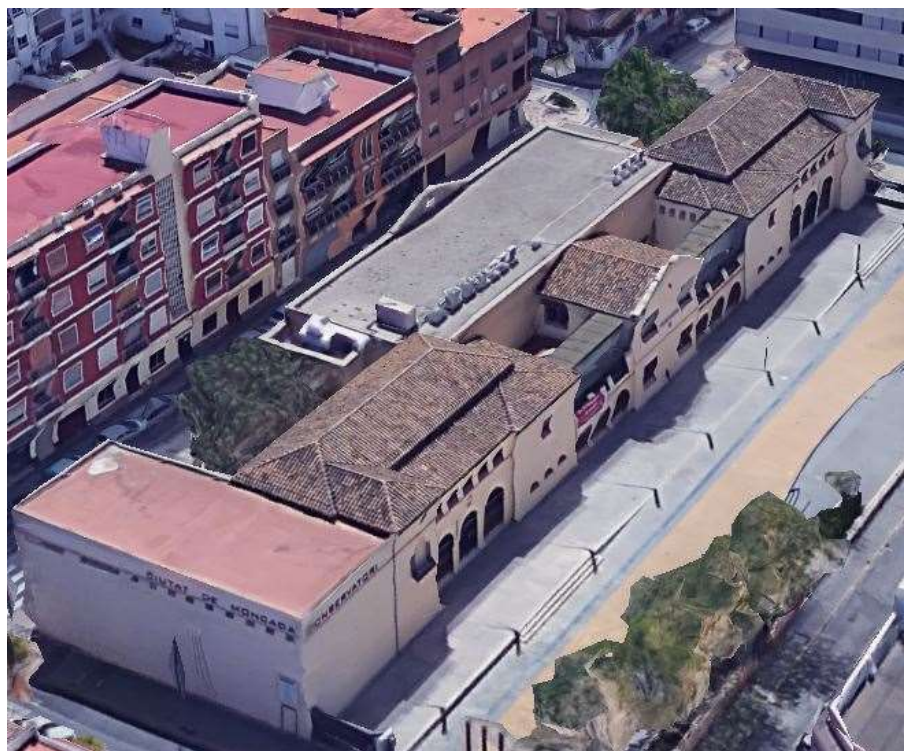
Figura 143. Perspectiva del Conservatorio aspecto actual. Fuente: Google Earth.
