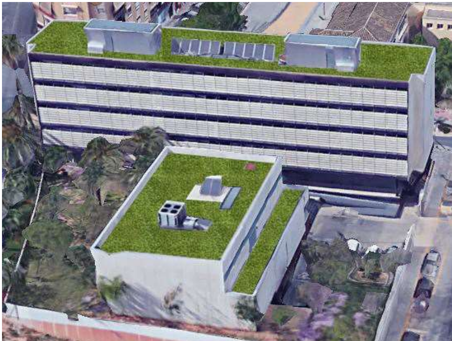
Figura 142. Propuesta de diseño de tejado verde para el Cuartel de la Guardia Civil. Fuente: Elaboración propia.
