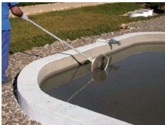
Figura 99. Retirada de flotantes en una laguna anaerobia. Fuente: Vicente Javier Macián.
