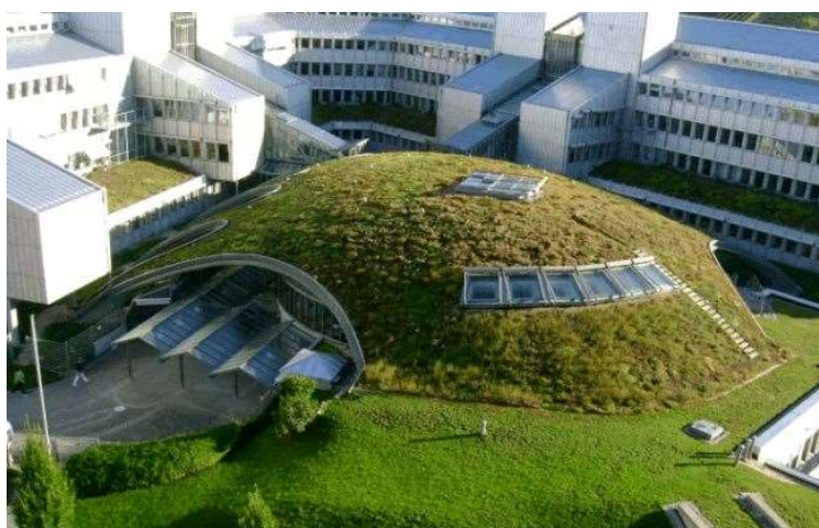
Figura 12. Ejemplo de cubierta de un edificio vegetada en Francia. Fuente: www.greenroofs.com .
