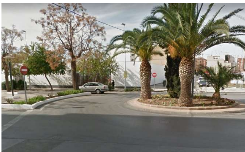
Figura 114. Rotonda de la calle Cementerio donde se produce encharcamientos. Fuente: Google Earth.
