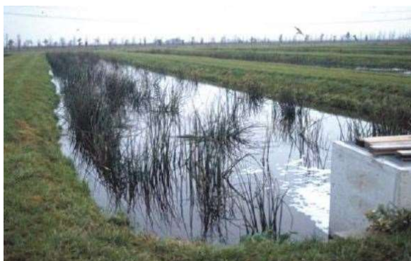
Figura 83. Humedal artificial de flujo superficial. Fuente: Miguel Martín Monerris, UPV.
