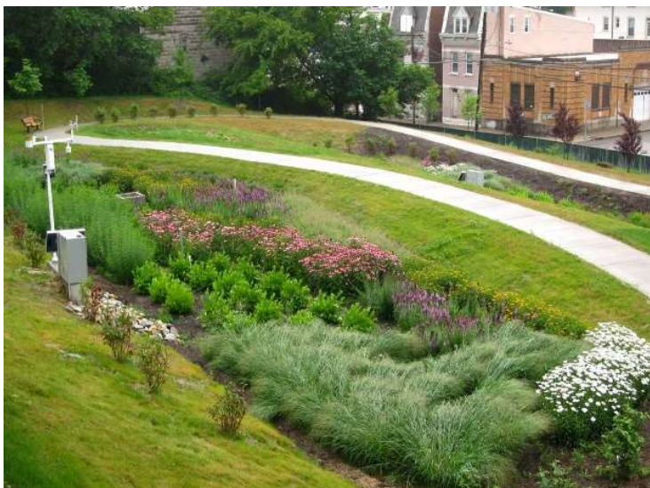
Figura 7. Área de biorretención en una zona en pendiente. Fuente: www.sudsostenible.com .
