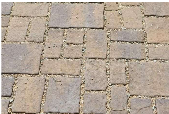
Figura 79. Pavimento de unidades modulares de piedra natural con juntas permeables. Fuente: www.sudsostenible.com .
