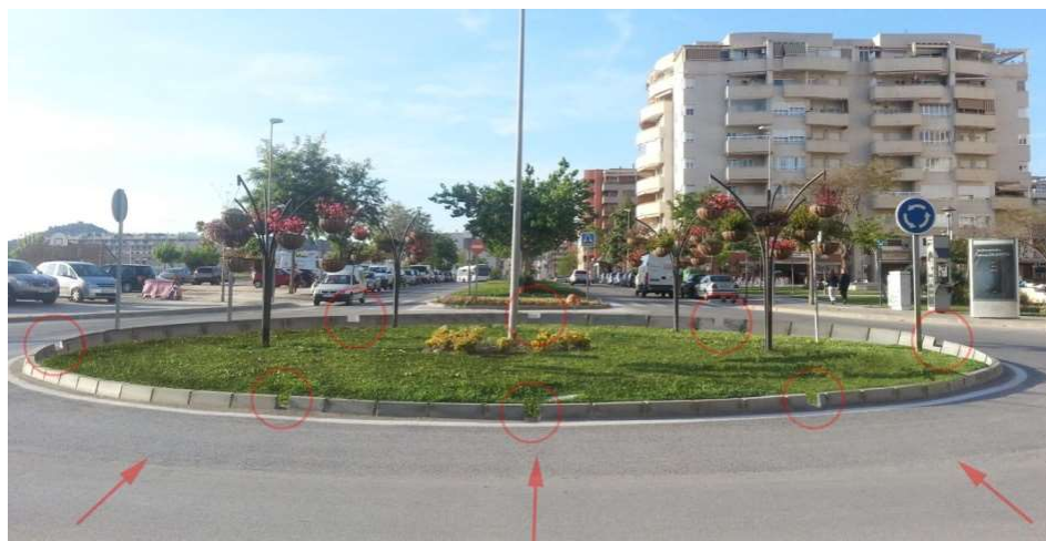
Figura 121. Ejemplo de rotonda con SUDS. Fuente: www.hidrologiasostenible.com .
