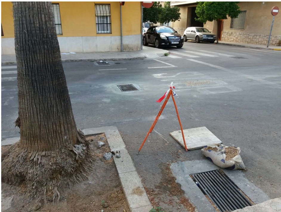
Figura 55. Sumideros de la calle Valencia. Fuente: Autor.
