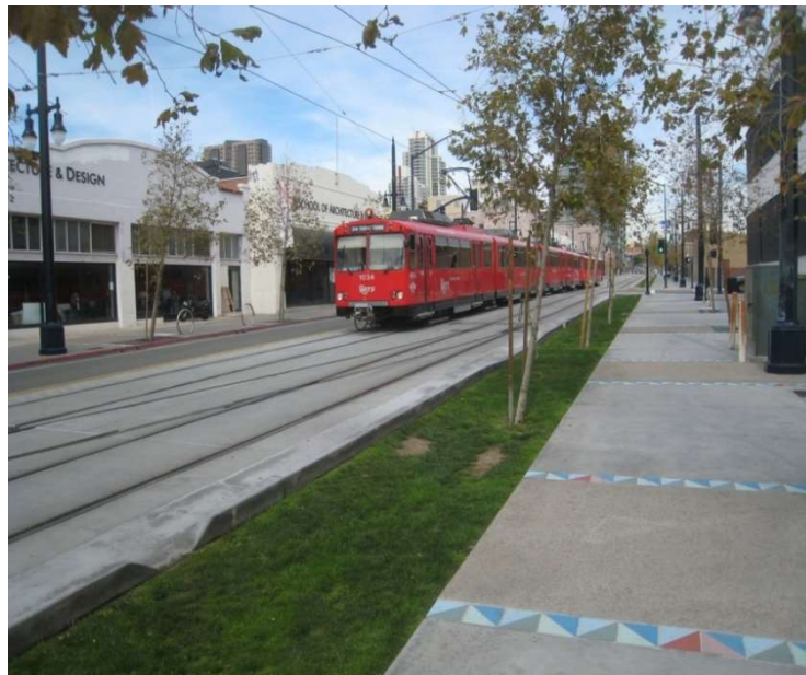
Figura 13. Ejemplo de franja filtrante separando la zona del tranvía de la acera.
