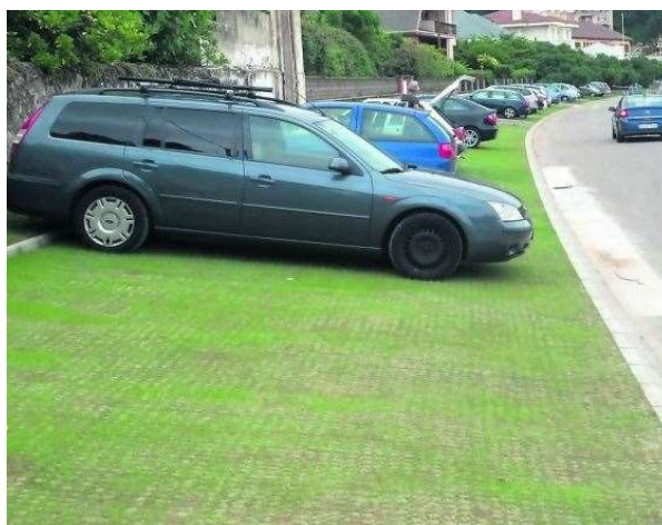
Figura 78. Pavimento permeable de césped reforzado en Salinas, Asturias. Fuente: J.F.C. periódico El Comercio.
