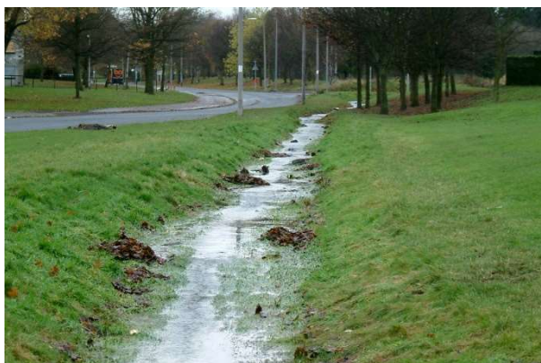
Figura 16. Canal de drenaje en Inglaterra.
