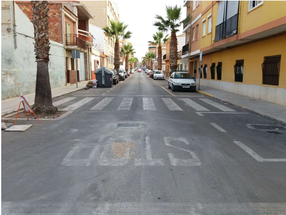
Figura 54. Sumideros de la calle Valencia. Fuente: Autor.
