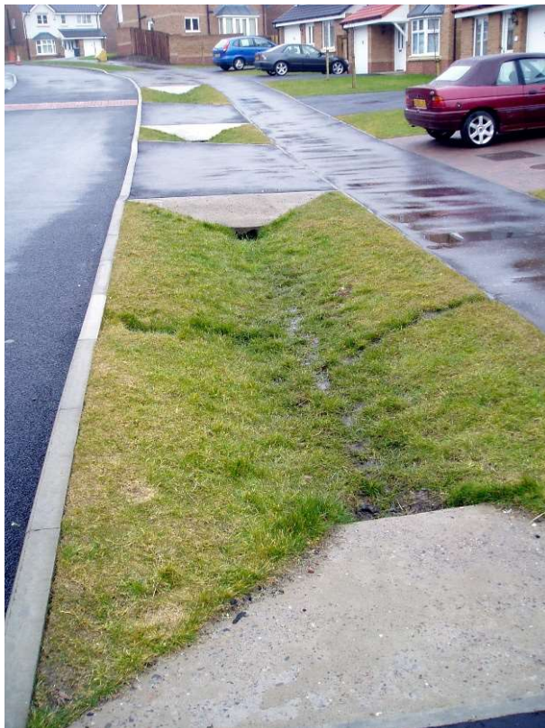
Figura 17. Canal de drenaje en un barrio residencial de Inglaterra.
