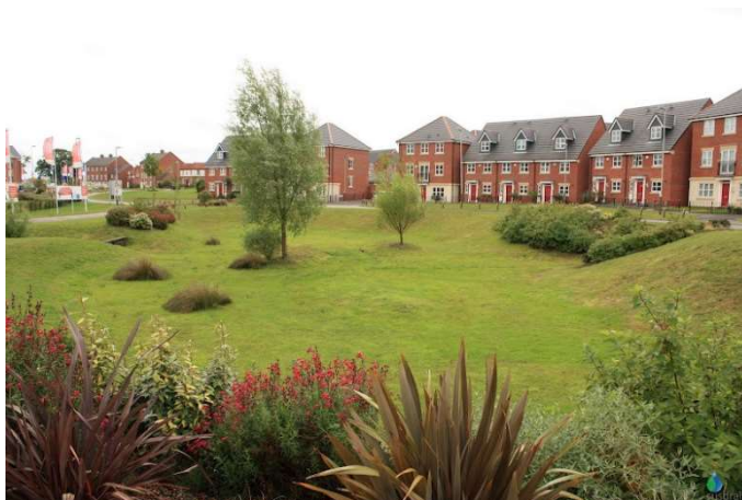
Figura 20. Ejemplo de cuenca de detención, Hamilton, Leicester, Reino Unido.
