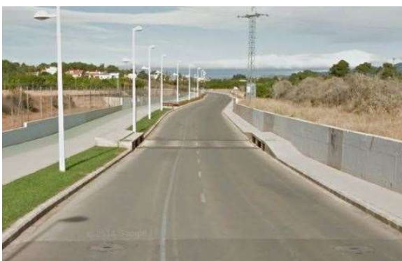
Figura 110. Calle 130, zona sur. Fuente: Google Earth.
