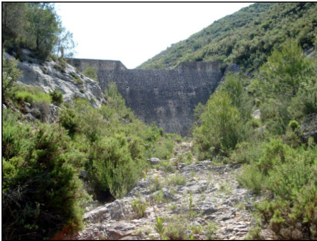
Imagen 24. Dique del barranco de les Foyes. Fuente: Servicio forestal de Alicante
