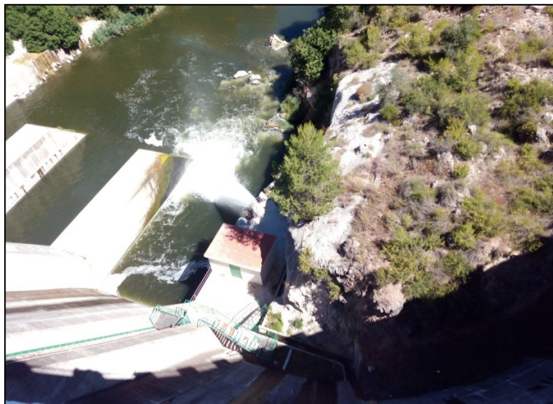
Imagen 12. Presa de Beniarrés con el desagüe de fondo en funcionamiento. Fuente propia.
