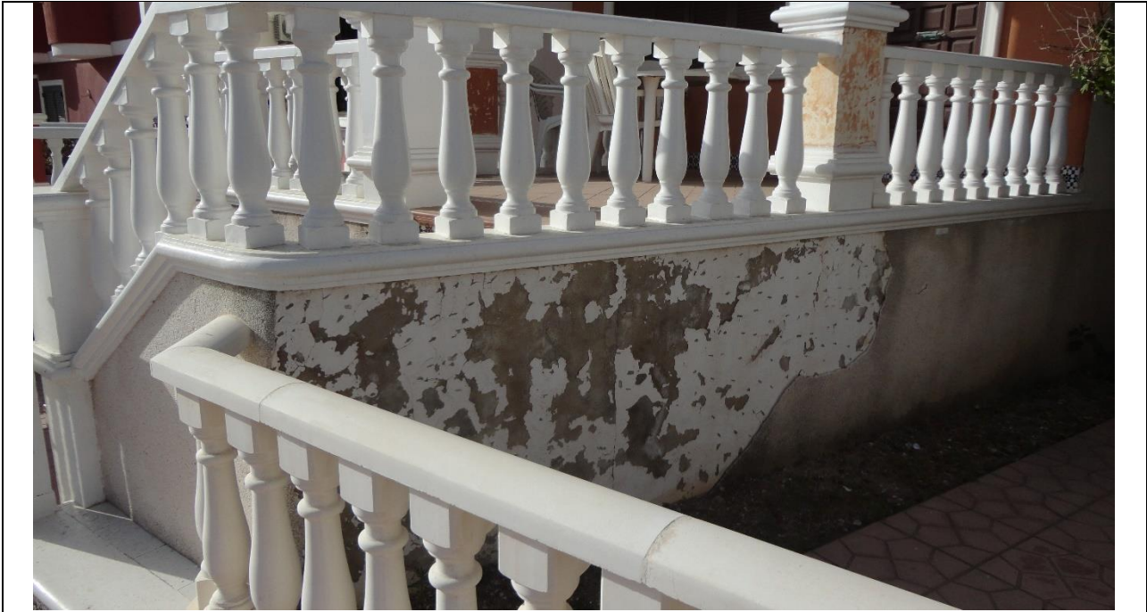
Figura 11. Fotografía Avd de la Llibertat 72. Fuente: Elaboración propia.
