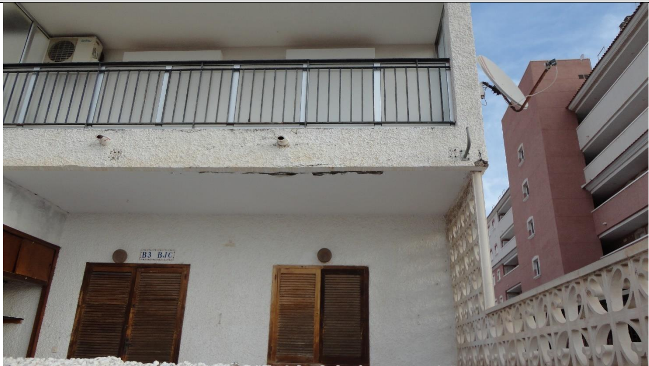
Figura 8. Fotografía Calle Tritón 2b. Fuente: Elaboración propia.
