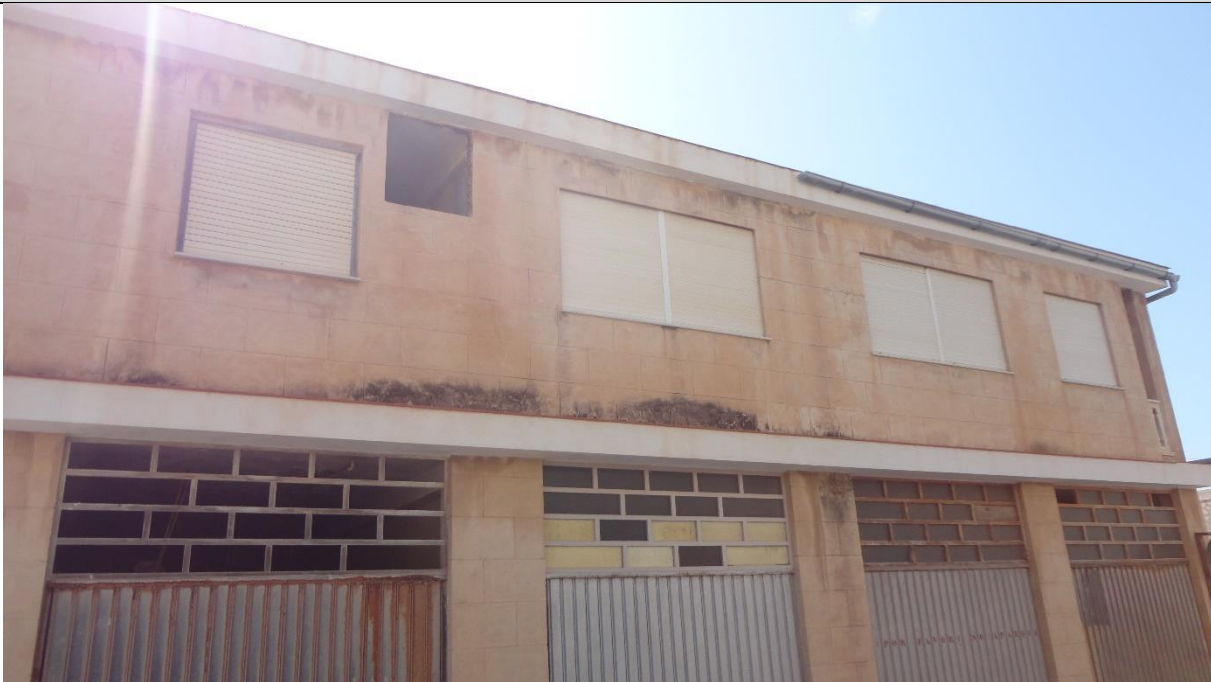
Figura 23. Fotografía Calle Cruz del Mar M3 . Fuente: Elaboración propia.
