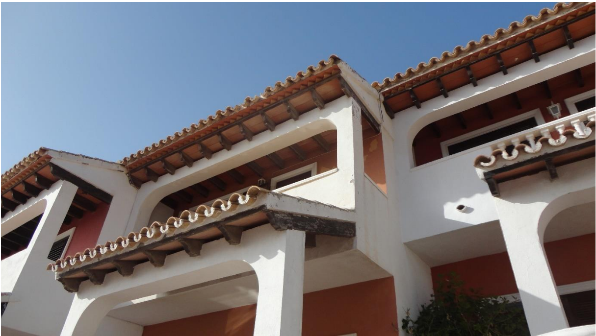
Figura 12. Fotografía Avd de la Llibertat 72. Fuente: Elaboración propia.
