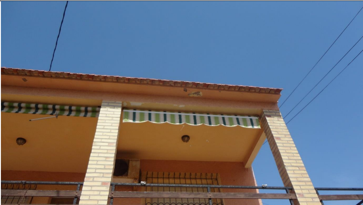
Figura 25. Fotografía Calle de la Rosa 16 . Fuente: Elaboración propia.
