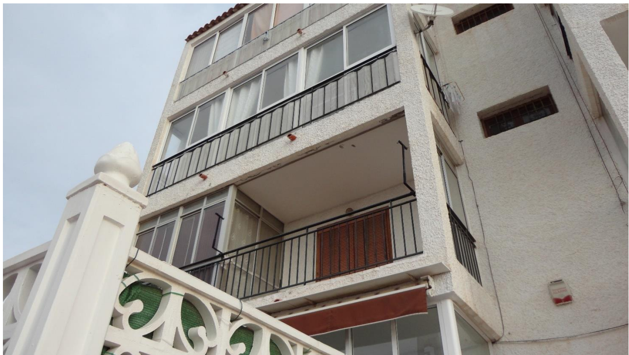
Figura 9. Fotografía Calle Tritón 2b. Fuente: Elaboración propia.
