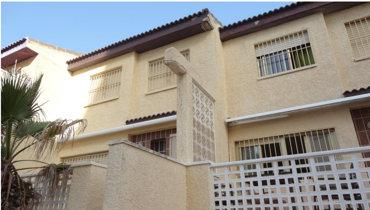
Figura 16. Fotografía Avd de la Llibertat 92. Fuente: Elaboración propia.
