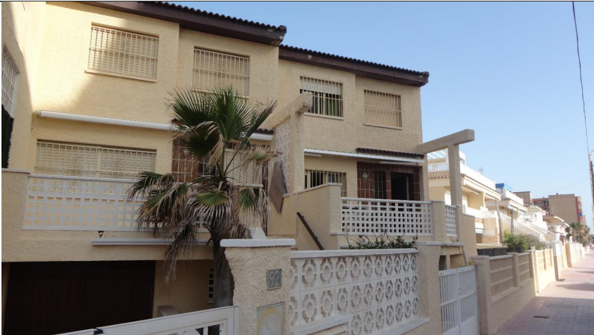
Figura 15. Fotografía Avd de la Llibertat 92. Fuente: Elaboración propia.
