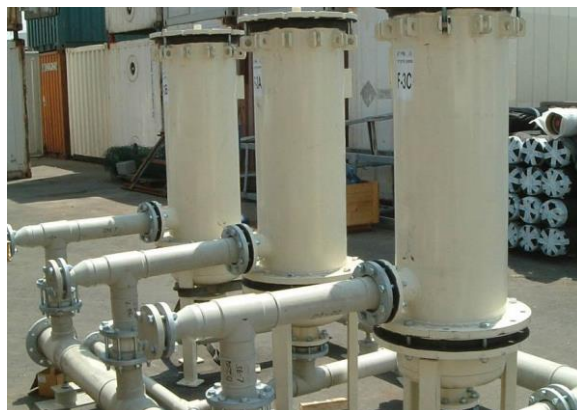
Figura 5-5. Filtros de cartucho para pretratamiento
