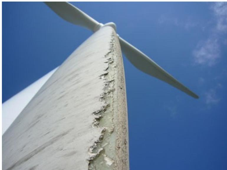
Figura 2.5: Deterioro en el borde de ataque de una pala de aerogenerador (Fuente: [www.hogrehojder.se](http://www.hogrehojder.se))
