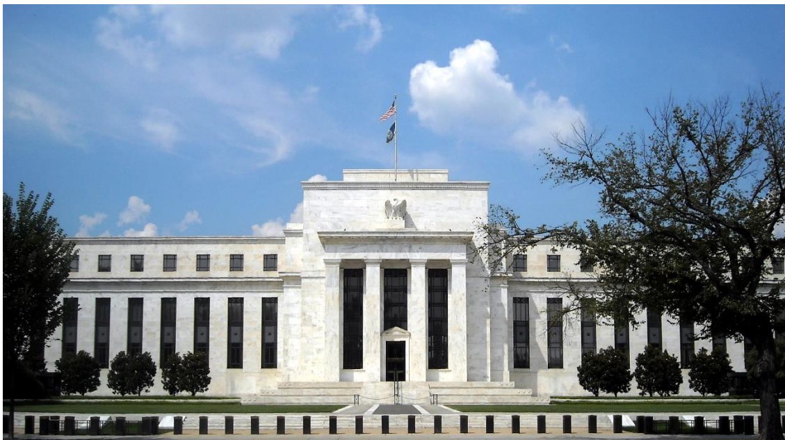
Imagen 3 Eccles Building (edificio de las oficinas centrales del Board of Governors de la Fed (Wikipedia, 2017)
