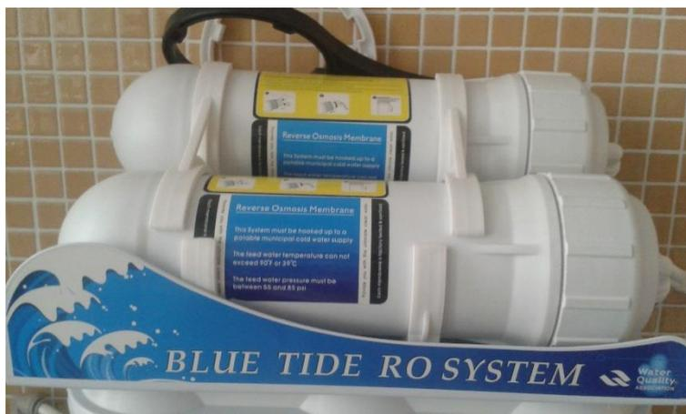
Ilustración 19. Membranas de osmosis inversa utilizados para la obtención de agua desionizada.
