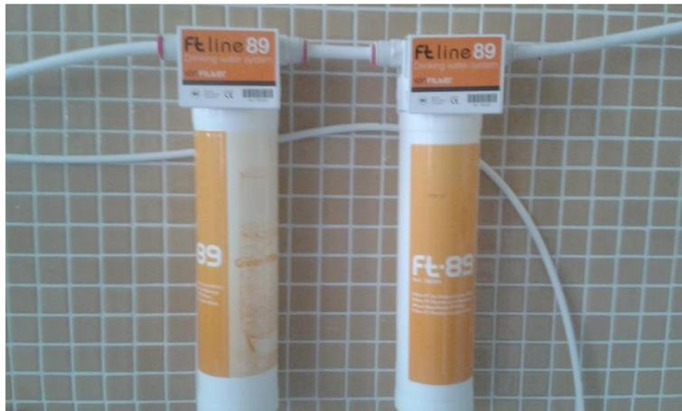
Ilustración 18. Filtros de resina utilizados para la obtención de agua desionizada.
