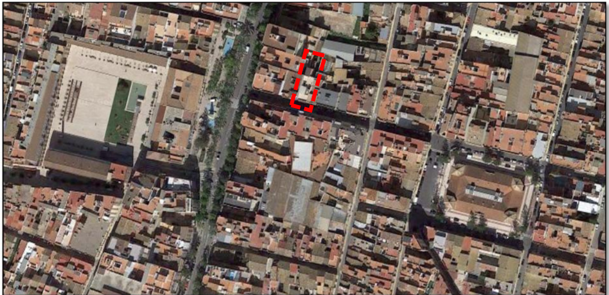
Figura 48. Situación del edificio en estudio. Año 2017. Fuente: Google Maps.
