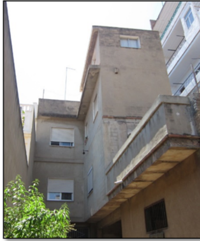
Figura 51. Fachada posterior del edificio en estudio. Año 2017. Fuente propia.
