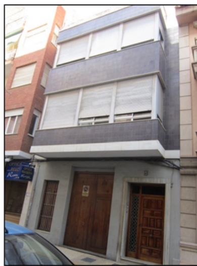
Figura 50. Fachada principal del edificio en estudio. Año 2017. Fuente propia.
