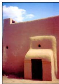
Figura 36. Refrigeración por alta masa térmica. Año 2006. Fuente: "Principios y estrategias del diseño bioclimático en la arquitectura y el urbanismo. Eficiencia energética"
