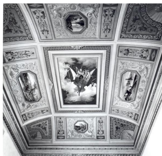
Fig. 41- la Sala 254 dopo il restauro
