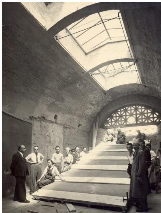
Fig.18 – Un'altra vista del cantiere della Casa di Livia al Palatino
