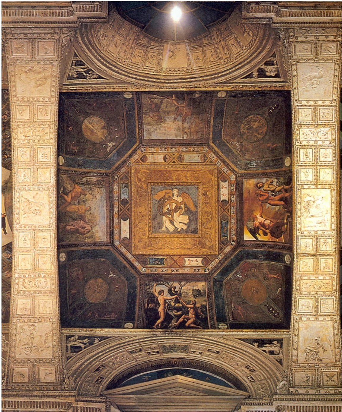
Fig. 37 – La volta della II° campata della Loggia, trattata con l'alluminato di potassio.
