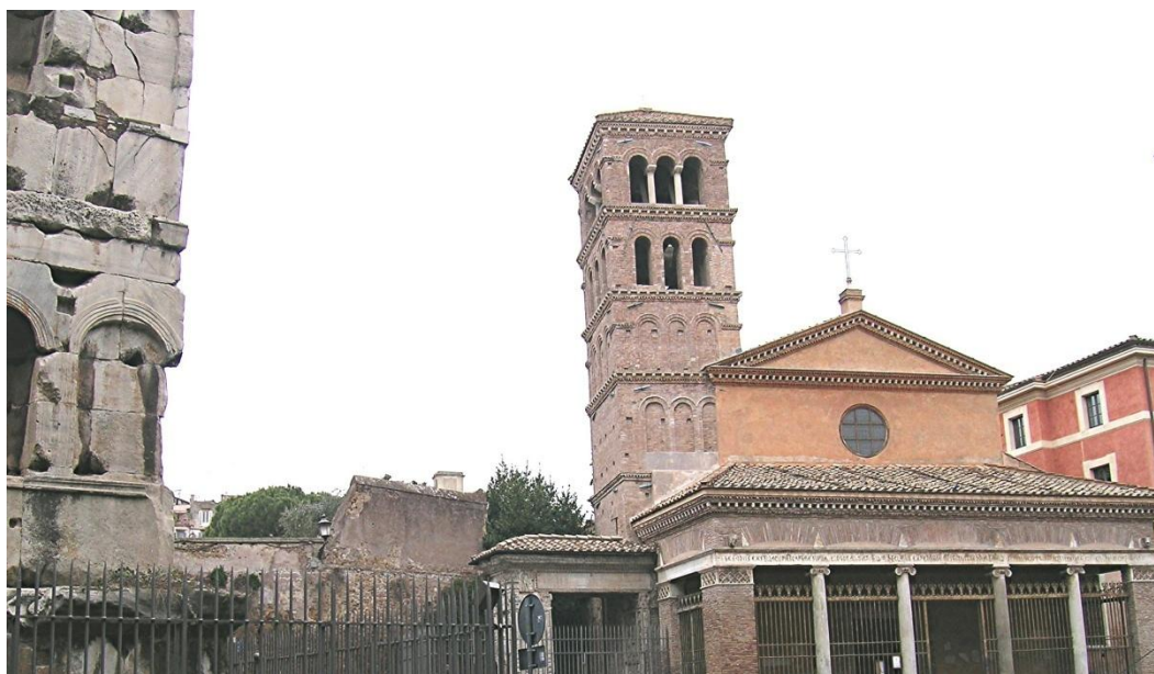
Fig. 2 – La chiesa di San Giorgio in Velabro vista dalla casa di Colalucci
