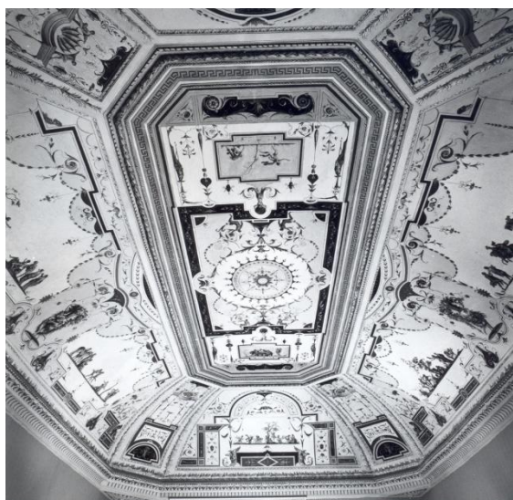
Fig. 40 – la Sala 115 dopo il restauro
