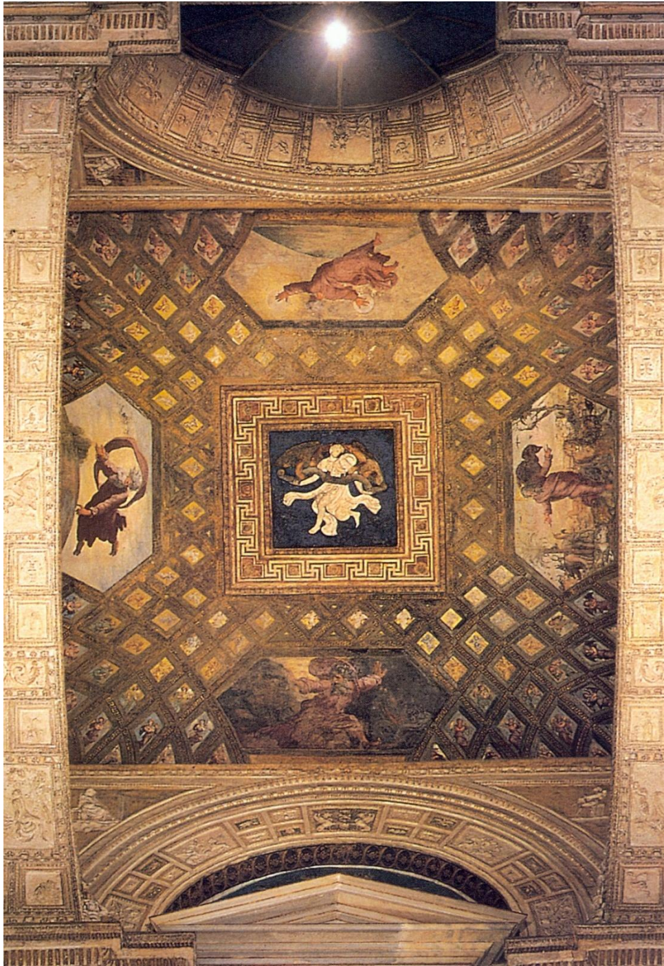
Fig. 36 – La volta della 1° campata della Loggia, trattata con l'alluminato di potassio.
