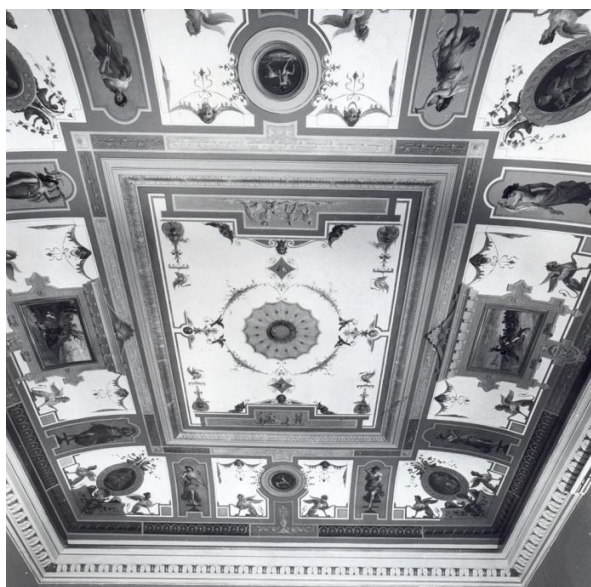
Fig.38- la Sala 256 dopo il restauro
