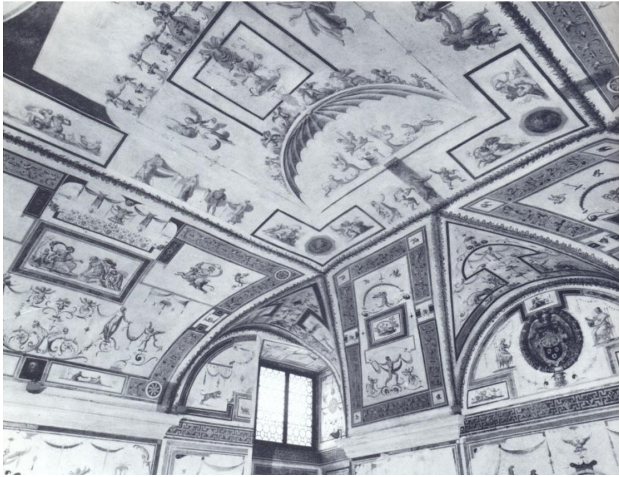
Fig. 23 – particolare della Volta dopo il restauro
