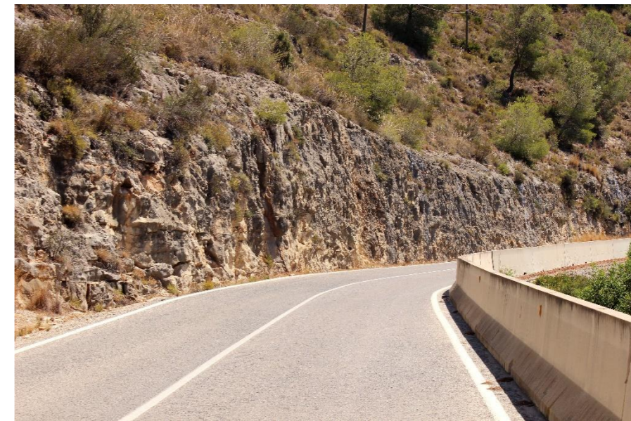
Ilustración 5. Detalle de talud en desmorte PK 835+000.
