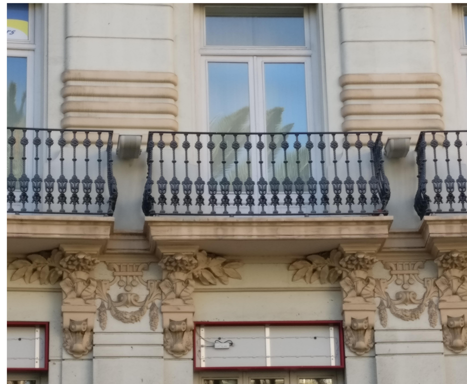
Imagen 37: Detalle molduras balcones
