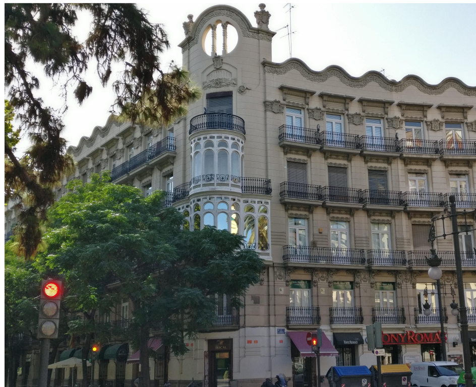
Imagen 36: Fachada principal, Gran vía Marqués del turia 71
