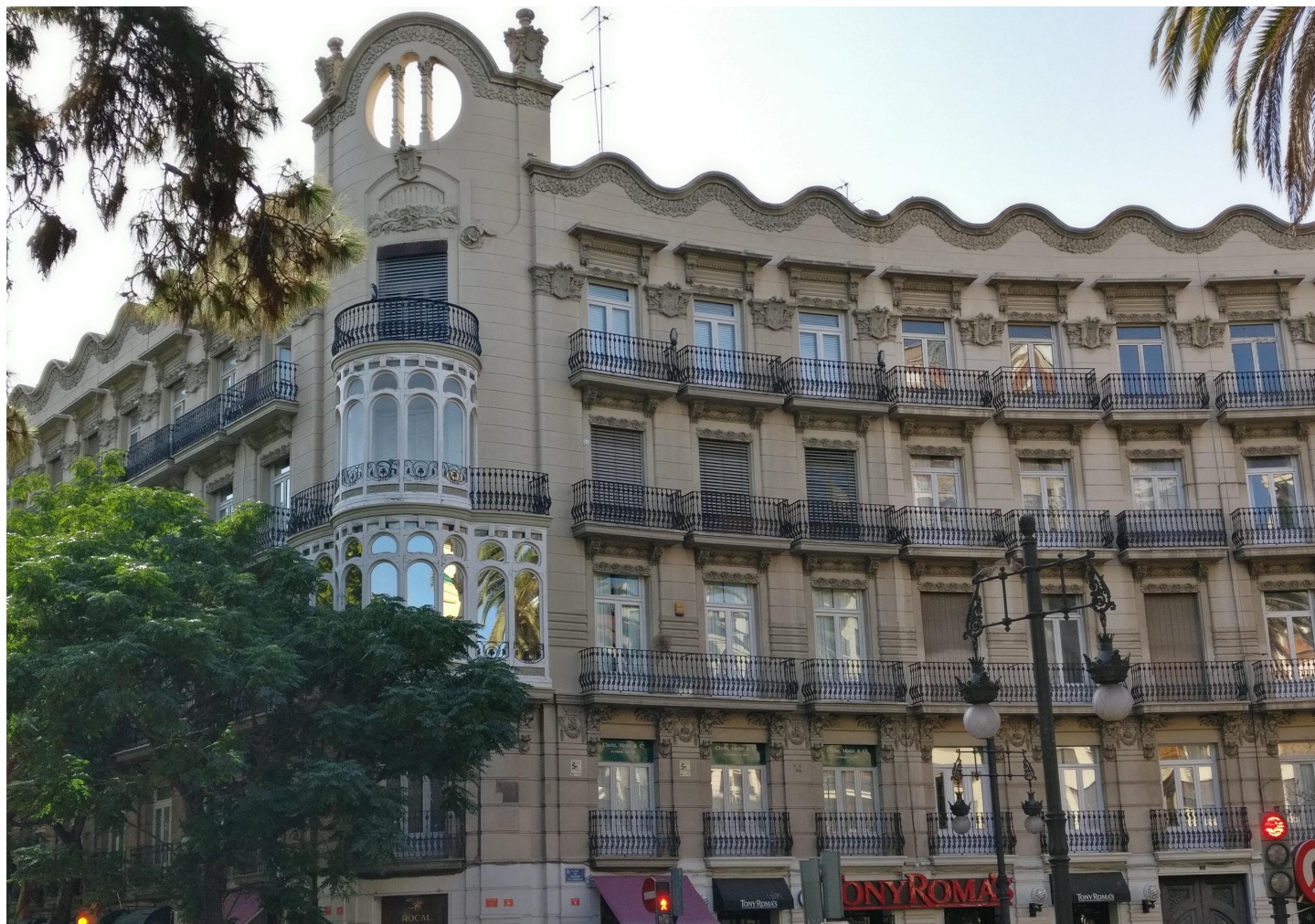
Imagen 1: Edificio Chapa Gran via Marques del turia 71
