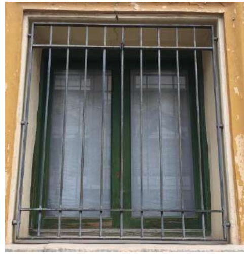
Figura 25: Imagen Ventana de Planta baja. 2016. Fuente Propia
