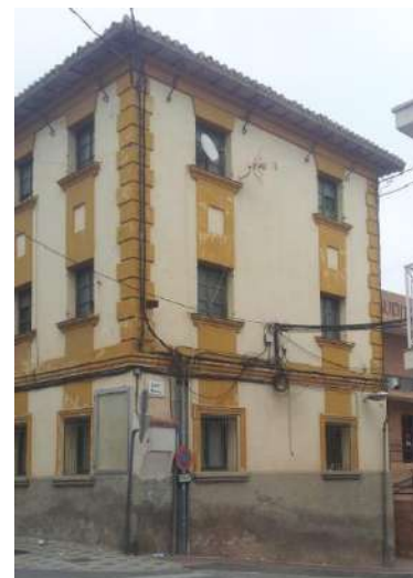
Figura 40: Fachada lateral. 2016. Fuente Propia
