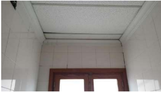
Figura 41: Imagen de revestimientos en aseos. 2016. Fuente Propia
