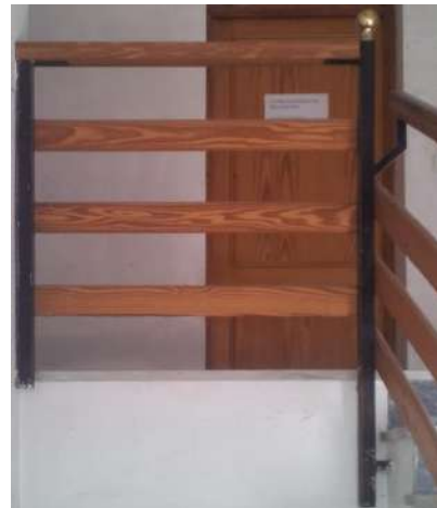
Figura 26: Imagen de barandilla de escalera. 2016. Fuente Propia
