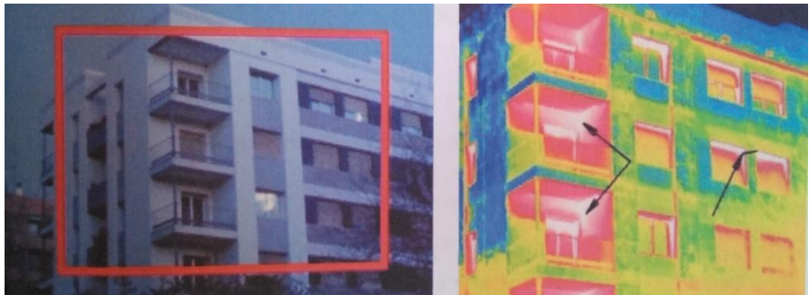
Ilustración 12 Fotografía con cámara termográfica. Fuente: Termograf, control y servicios termográficos
