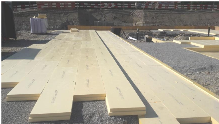
Ilustración 15 Aislante térmico en solera de hormigón para un colegio en Suiza. Fotografía propia.
