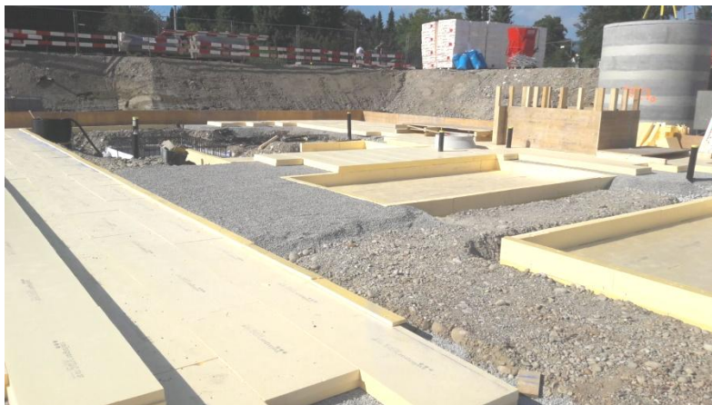
Ilustración 15 Aislante térmico en solera de hormigón para un colegio en Suiza. Fotografía propia.
