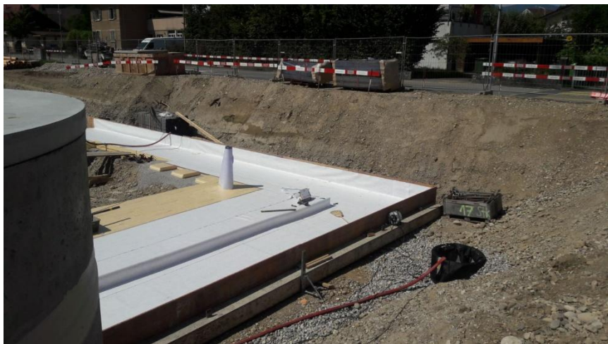
Ilustración 17 Lámina impermeable para un colegio en Suiza. Fotografía propia.
