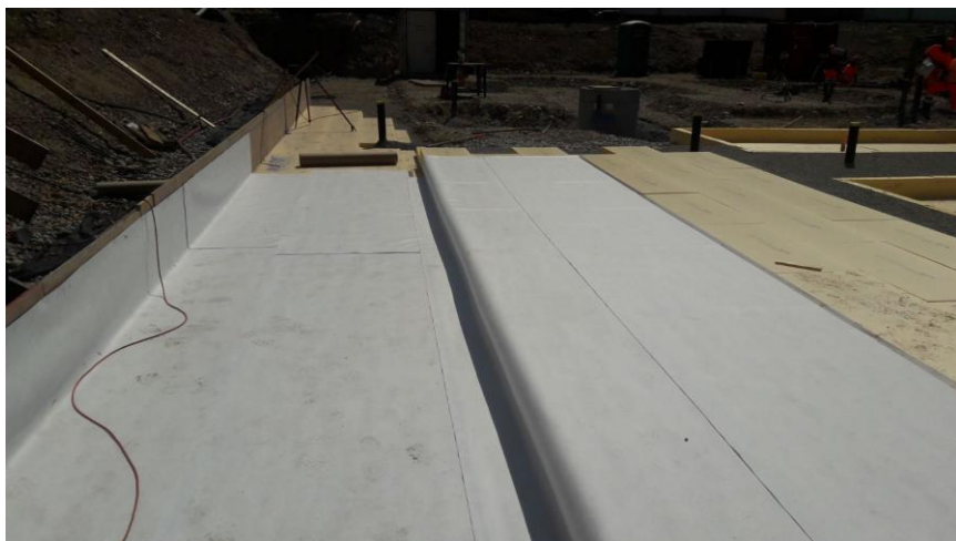
Ilustración 17 Lámina impermeable para un colegio en Suiza. Fotografía propia.
