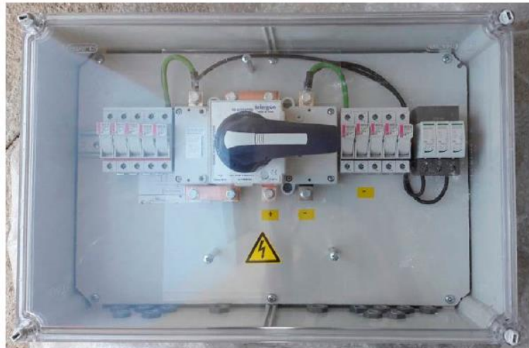
Imagen 16: Caja de conexiones CC
