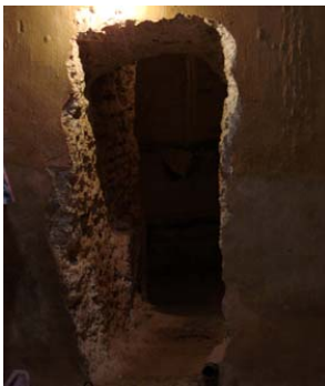
437 - Puerta de entrada de la cisterna (túnel) del Palau dels Borja, en Gandia.
