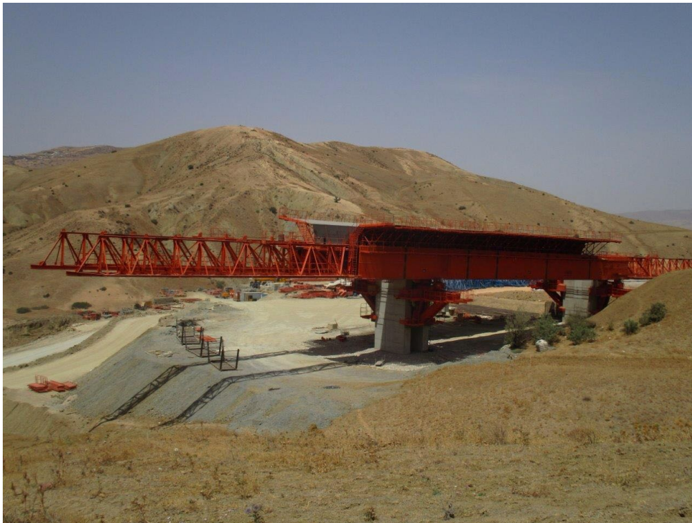
Fig 14. Ejecución del tablero con autocimbra. Fuente: LIC.
