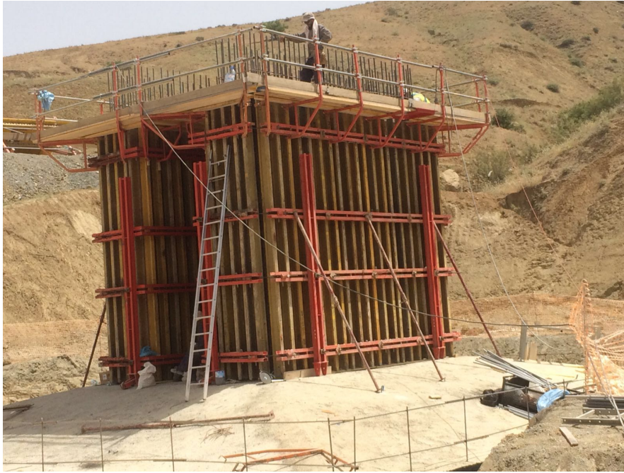
Fig 13. Sección de arranque con encofrado especial. Fuente: LIC
