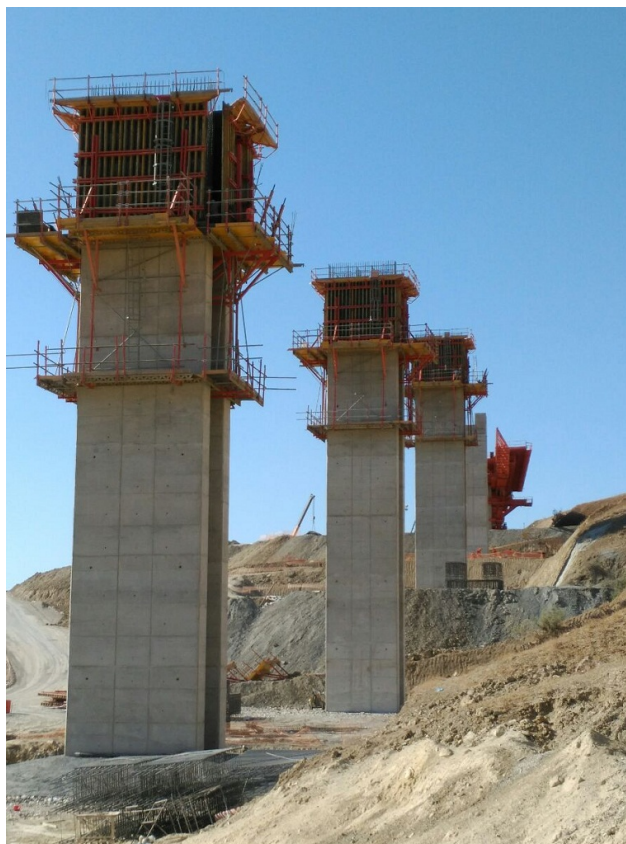
Fig 12. Ejecución de las pilas mediante trepas. Fuente: LIC
