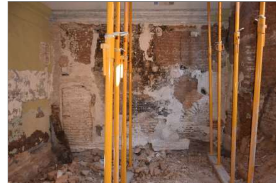
Figura 63. Apuntalamiento y suelo excavado sala 1AC. Año 2016. Imagen propia.
