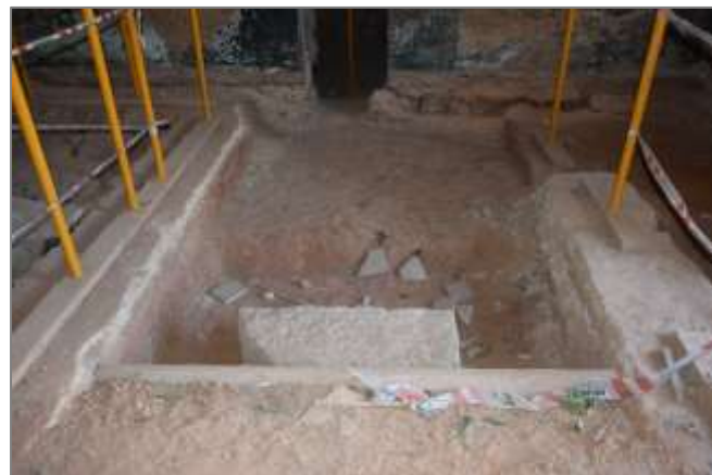
Figura 62. Cimentación vista nave 1B. Año 2016. Imagen propia.
