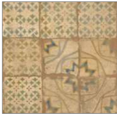
Figura 52. Solado sala 2DC. Año 2016. Imagen Ayto. de Valencia.
