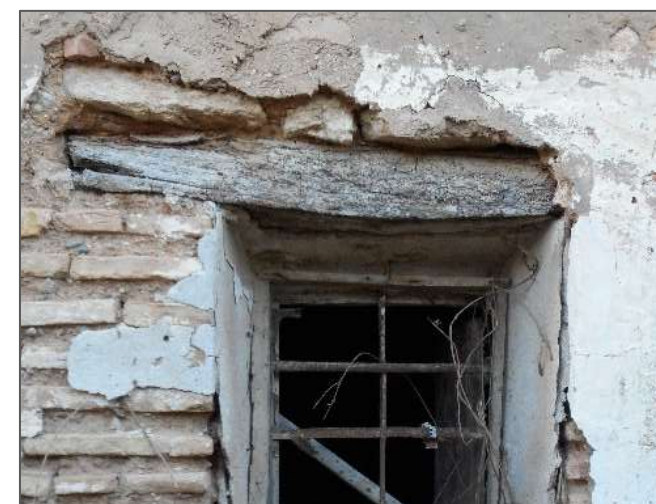
Figura 12. Dintel de madera en vano de ventana. Alquería del Moro. Año 2016. Fotografía de Gemma Mohedano
