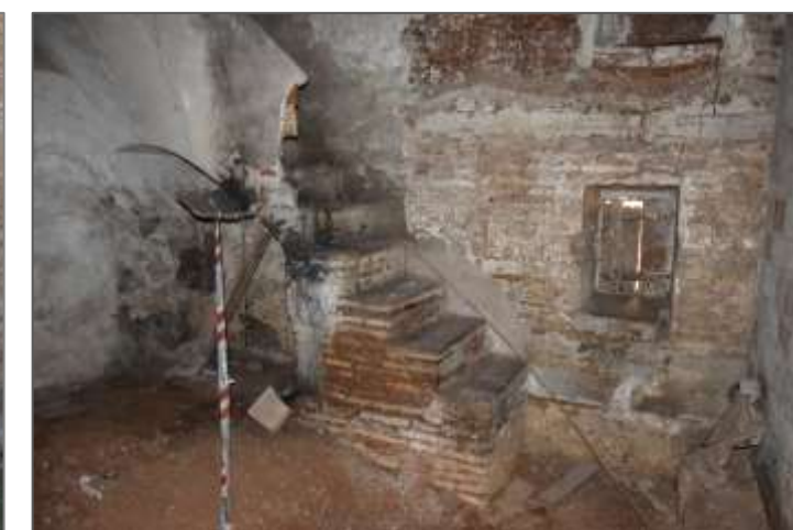
Figura 14. Escalera sobre bóveda tabicada. Alquería del Moro. Año 2016. Imagen propia.
