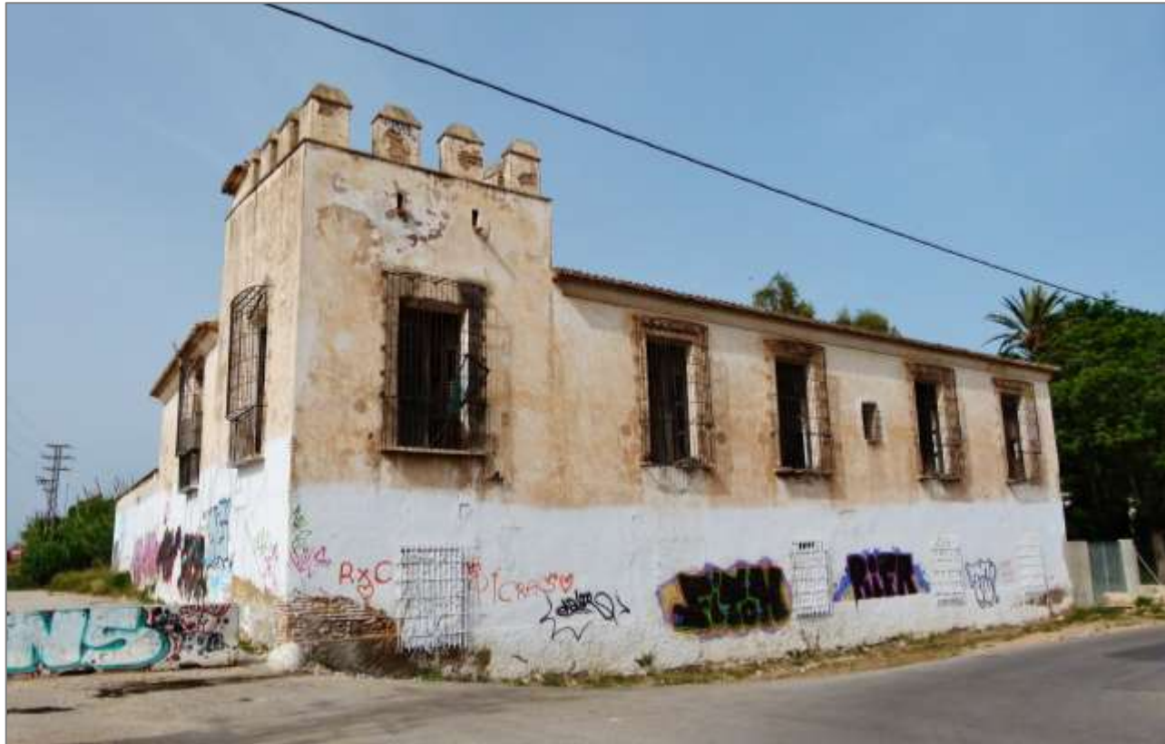
Figura 27. La Alquería de la Torre. Año 2017. www.patologiasyrehabilitacion.blogspot.com.es
