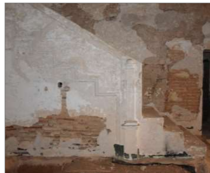
Figura 47. Escalera sala 1BB, revestida y decorada de yeso. Año 2016. Imagen propia.
