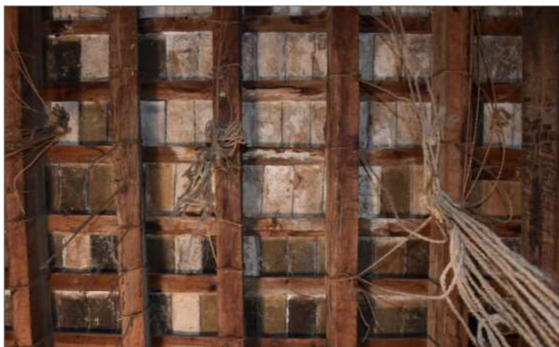
Figura 42. Vista interior cubierta inclinada de la Alquería del Moro. Año 2016. Imagen propia.
