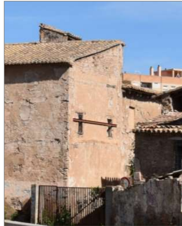
Figura 72. Anclaje y atirantado de la fachada de la sala 2D, interior y exterior. Año 2016. Imagen propia.
