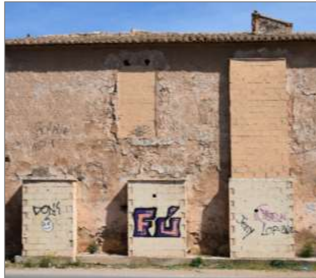
Figura 59. Tapiado de huecos de la fachada sur. Año 2016. Imagen propia.
