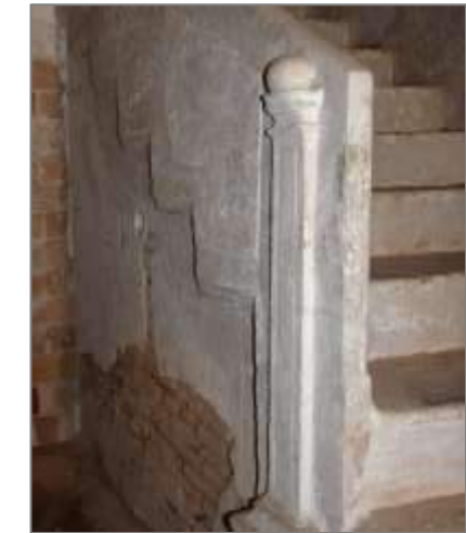
Figura 48. Revestimiento de yeso, escalera sala 1BB. Año 2016. Imagen propia.
