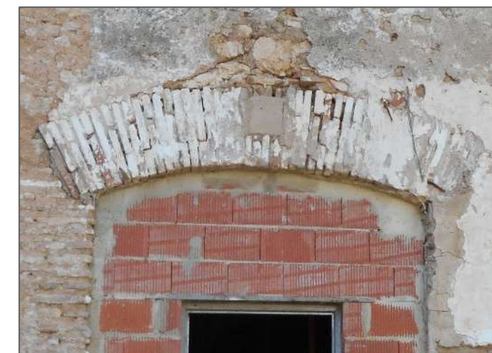
Figura 11. Arco de ladrillo en vano de puerta. Alquería del Moro. Año 2016. Fotografía de Gemma Mohedano.
