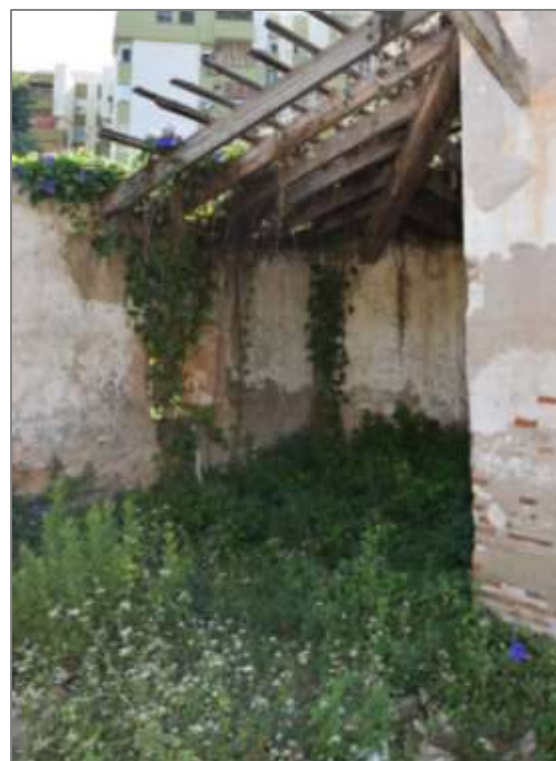
Figura 86. Zona de patio que requiere desbroce. Año 2016. Imagen propia.
