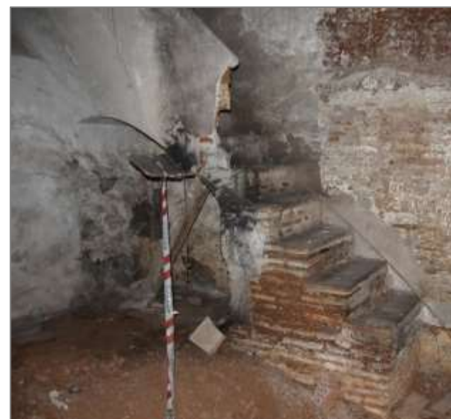
Figura 46. Escalera sala 1AA. Año 2016. Imagen propia.
