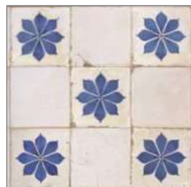
Figura 54. Solado sala 2C. Año 2016. Imagen Ayto. de Valencia.
