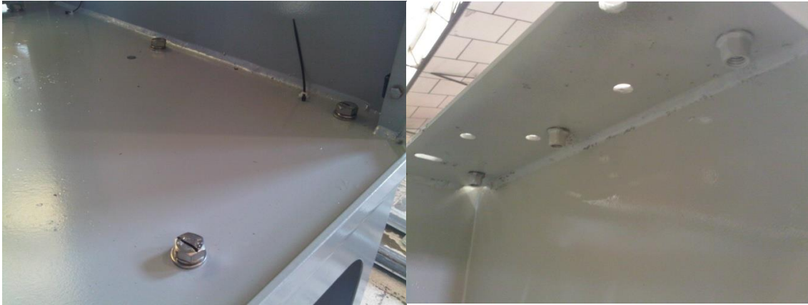
Ilustración 32. Ejemplo de unión atornillada entre columna y patín
