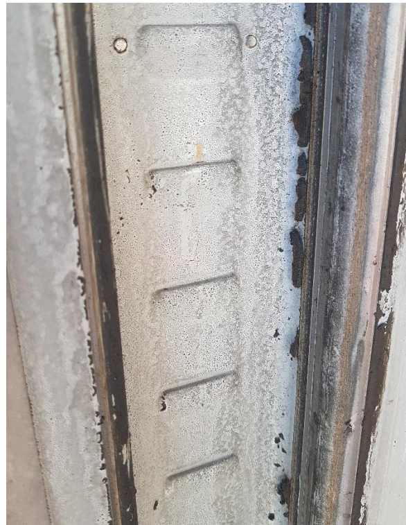
Ilustración 79. Dientes de enclavamiento sobre guía de las columnas.
