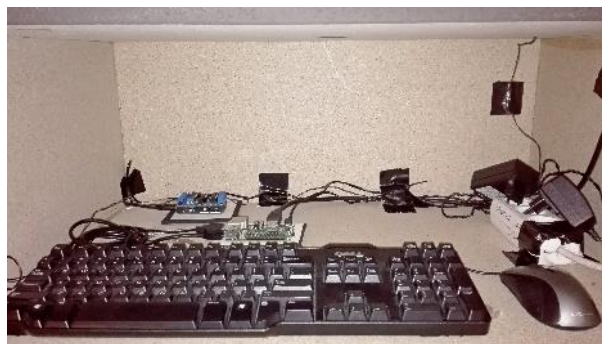
Fig. 57 Compartimento interno del pedestal con dispositivos electrónicos utilizados.
