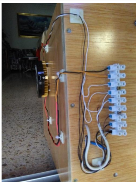
Cableamos e instalamos el ventilador exterior
