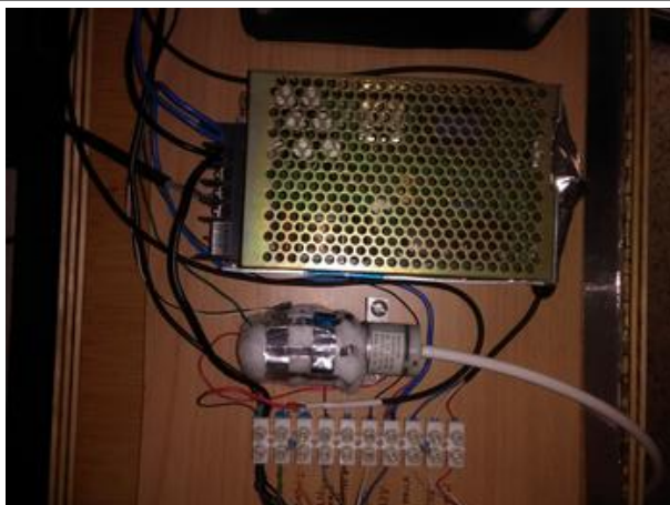
Vista final: conexión bornero bomba y fuente
