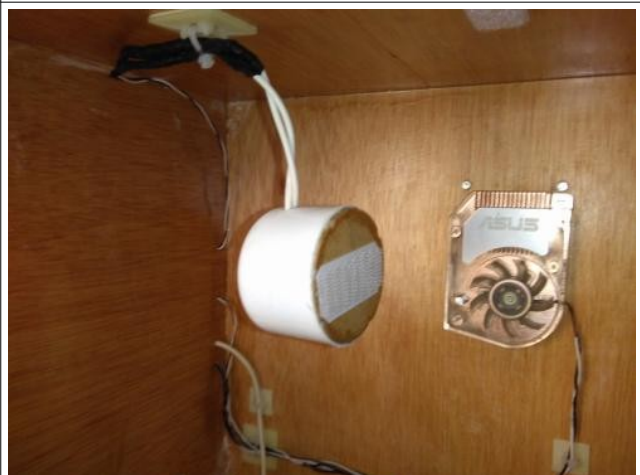
Instalación del led
