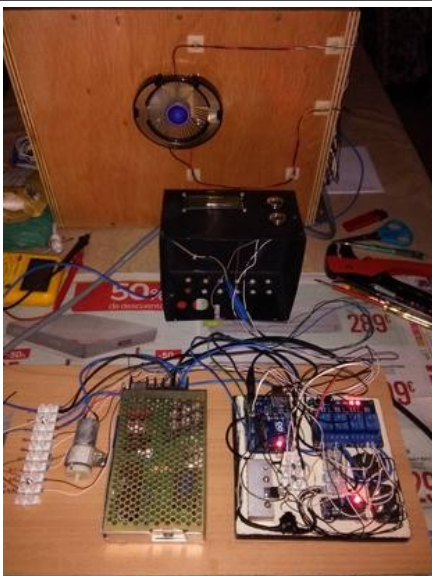
Vista final: tablero puesto en marcha
