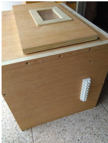
Instalación bornero de empalme
