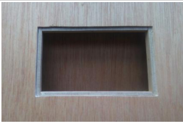
Pasamos a preparar el encajonado donde irá alojado el metacrilato de la ventana.
