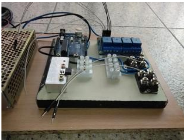
Y cableamos la caja de control principal
