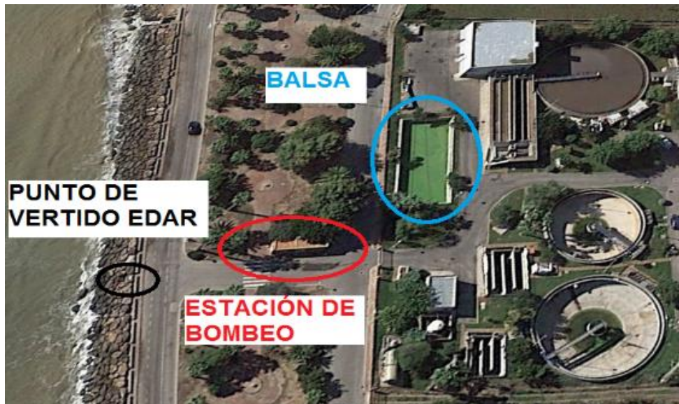
Figura 26. Depuradora de Borriana, situación de la balsa y la Estación de Bombeo de los regantes.
