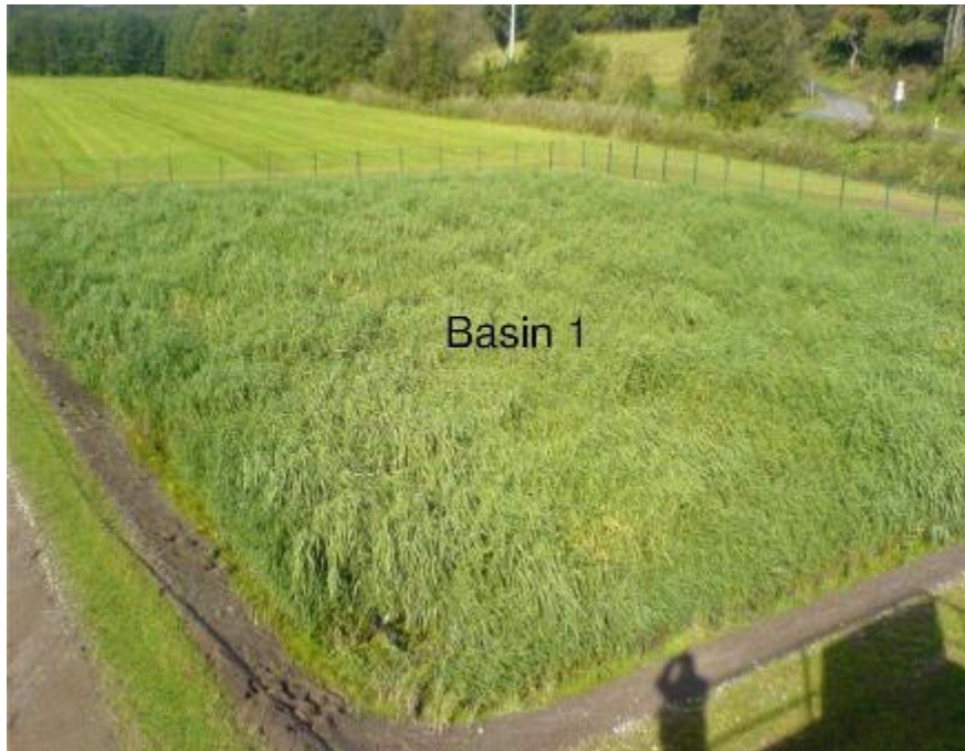
Figura 4 Celda del humedal de Silkerode. (Fuente: www.blumberg-engineers.de ).
