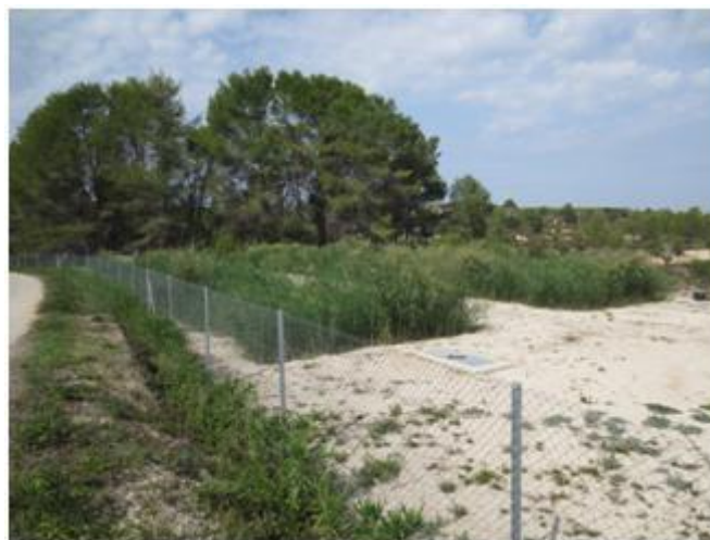
Figura 5. EDAR del municipio de Carrícola. (Fuente: Boletín Nº 3 Febrero 2015 www.iiama.upv.es ).
