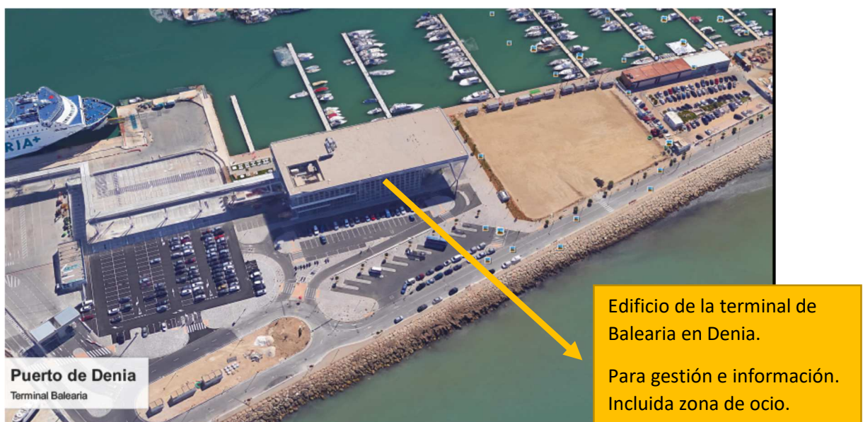
Figura 19. IMAGEN EDIFICIO TERMINAL BALEARIA
