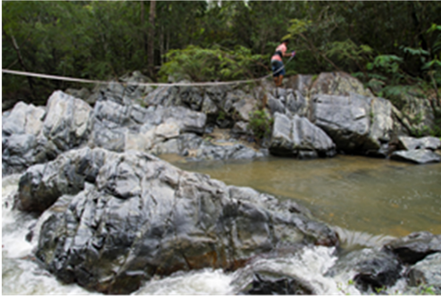
Figura 9. Toma de mediciones para la construcción de la obra de toma
