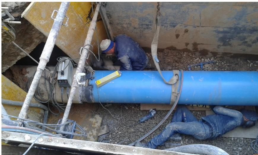
*Ilustración 78. Soldadura entre tubería de hormigón con camisa de chapa y tubería de acero*
