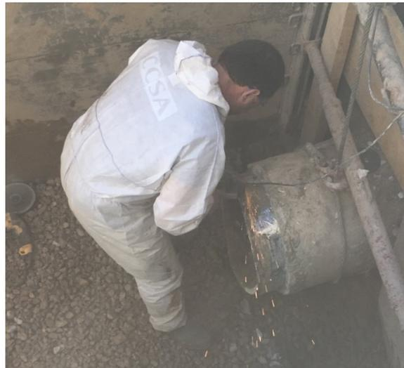
*Ilustración 84. Acondicionamiento de la camisa de chapa para realizar la soldadura*
