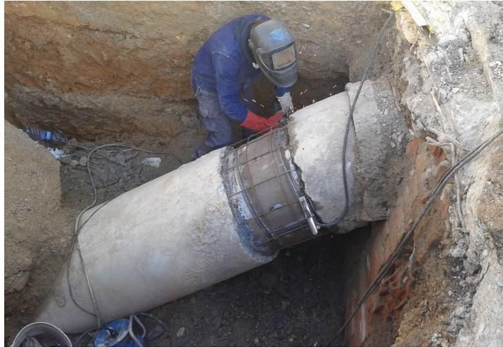
*Ilustración 75. Soldadura de la armadura del hormigón armado de recubrimiento de una tubería de hormigón con camisa de chapa*
