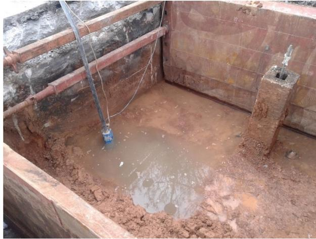
*Ilustración 43. Bombeo del agua de la excavación*
