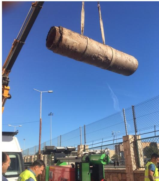
*Ilustración 83. Retirada de tubo de hormigón con camisa de chapa*
