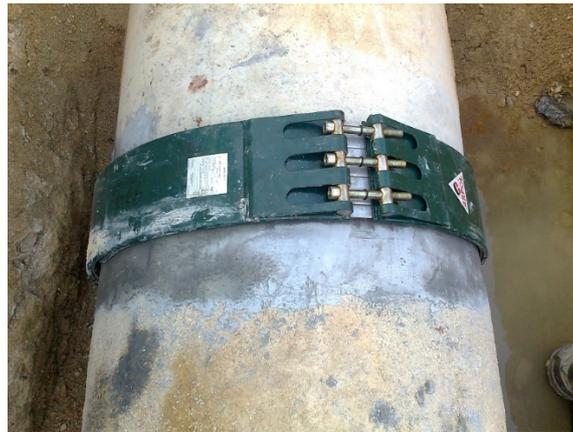
*Ilustración 72. Manguito de reparación para tubería de hormigón*
