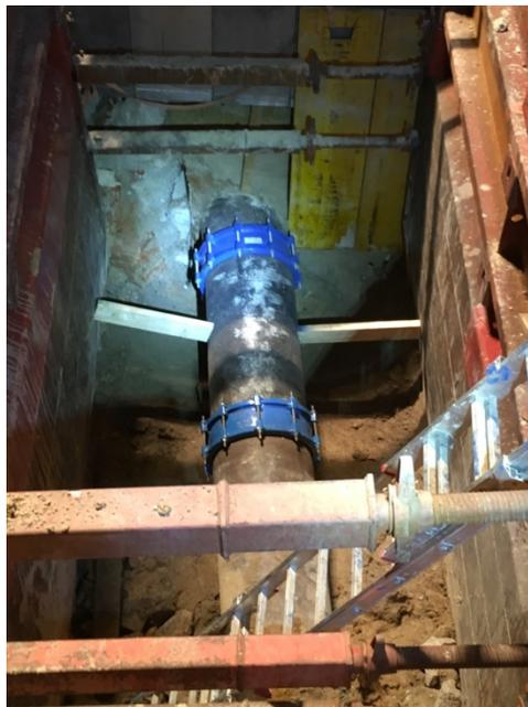
*Ilustración 58. Apoyos para la puesta en carga de una tubería tras la reparación*
