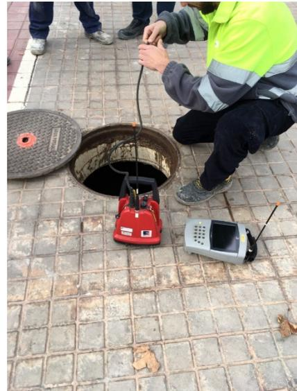
*Ilustración 39. Correlación tubería*
