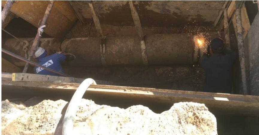
*Ilustración 81. Corte de la tubería mediante soplete*
