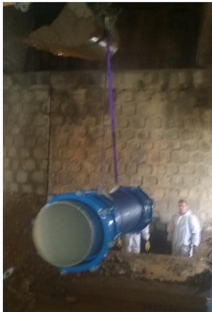
Ilustración 64. Transporte de tubo de reparación junto con los accesorios de unión
