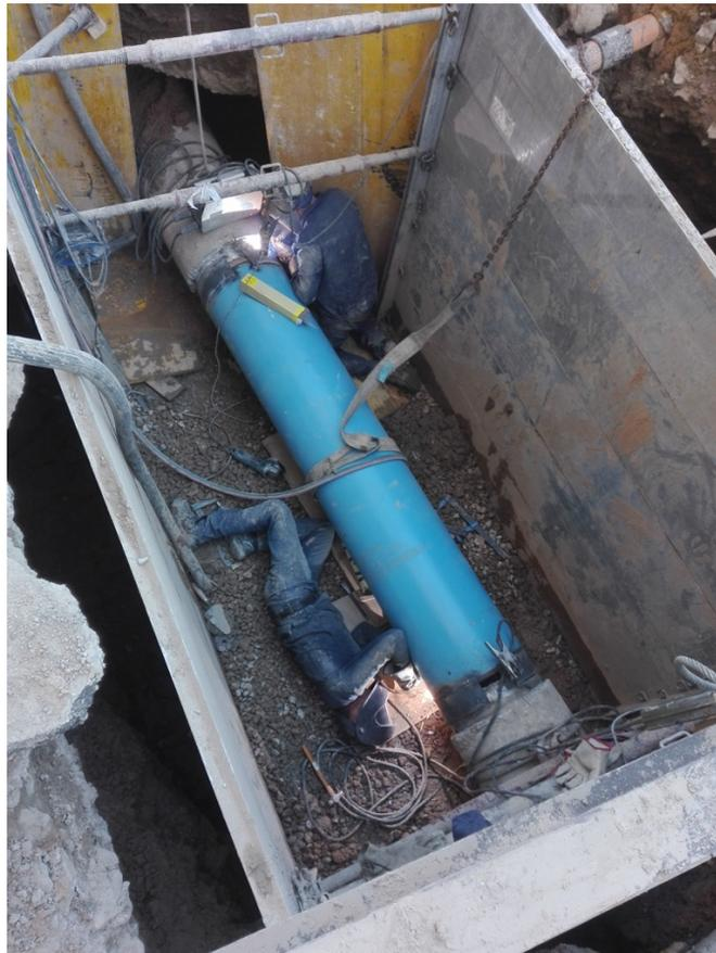
*Ilustración 85. Soldadura de tubo de acero con tubo de hormigón con camisa de chapa mediante virola*
