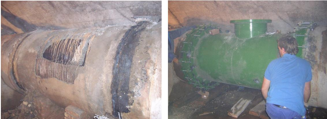
*Ilustración 77. Reparación de tubería de hormigón sin camisa de chapa*
