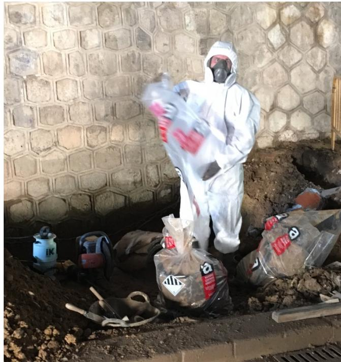
*Ilustración 70. Operario almacenando trozos de tubo en bolsas de plástico especiales*
