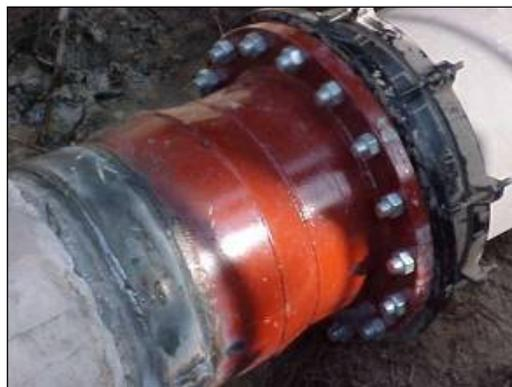
*Ilustración 88. Reparación mediante bridas*
