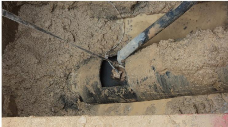
*Ilustración 92. Introducción de una bomba dentro de una ventana para realizar el achique del agua*
