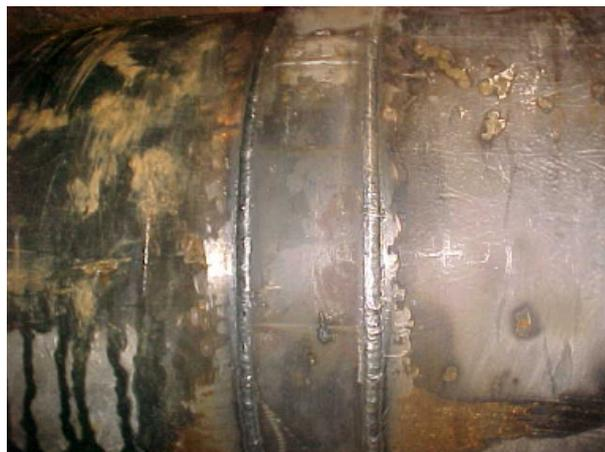
*Ilustración 94. Soldadura de la virola en una tubería de acero*
