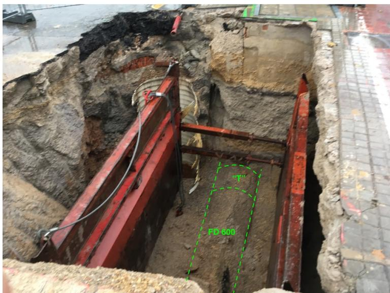
*Ilustración 100. Colocación de la entibación*
