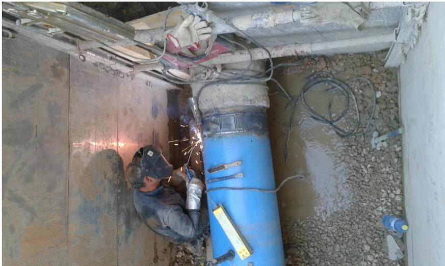
*Ilustración 91. Soldadura por arco eléctrico de una tubería de acero con una chapa de una tubería de hormigón con camisa de chapa*
