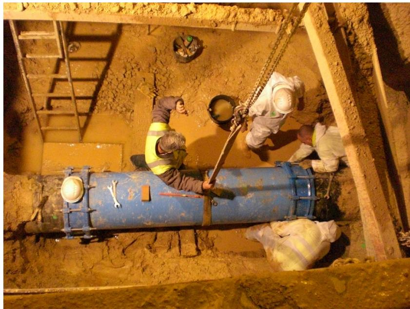
*Ilustración 93. Reparación de tubería de acero con piezas mecánicas*
