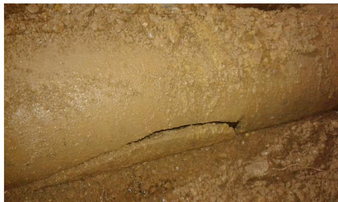
*Ilustración 34. Fisura en tubería de fibrocemento*
