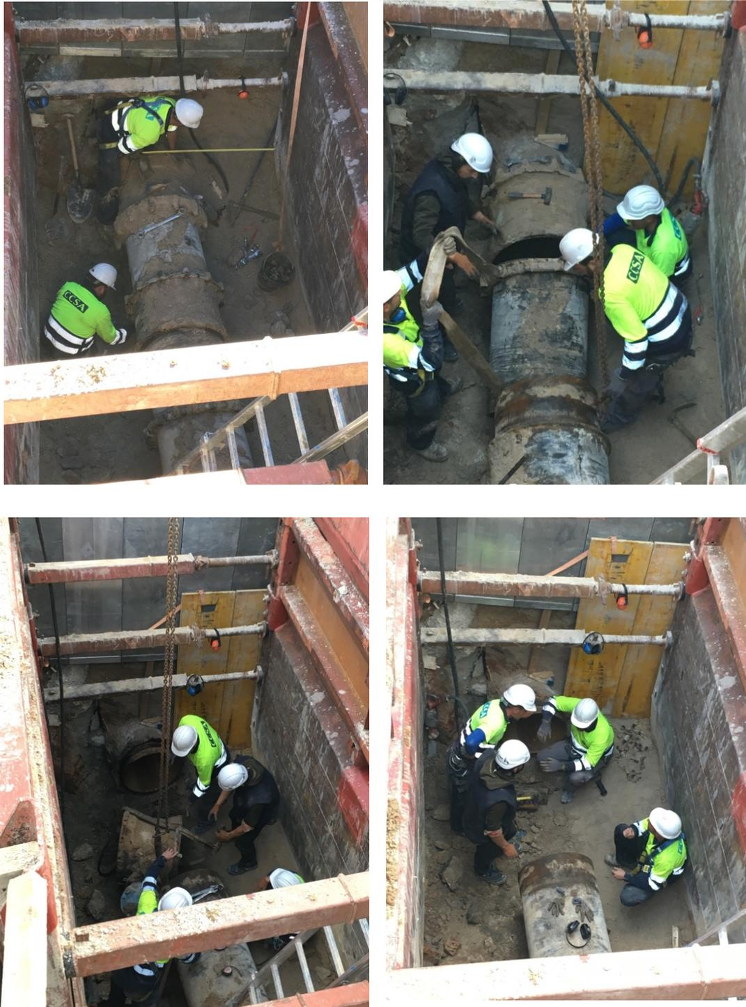
*Ilustración 103. Retirada de los elementos de la tubería*
