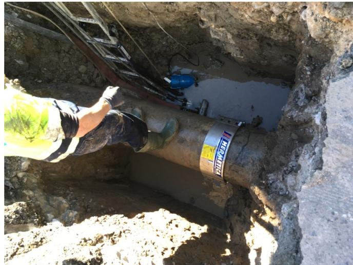
*Ilustración 59. Manguito de reparación en tubería de fibrocemento*
