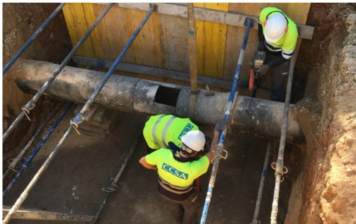
*Ilustración 50. Corte de tubería*
