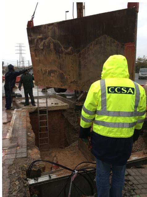
*Ilustración 107. Retirada de la entibación*
