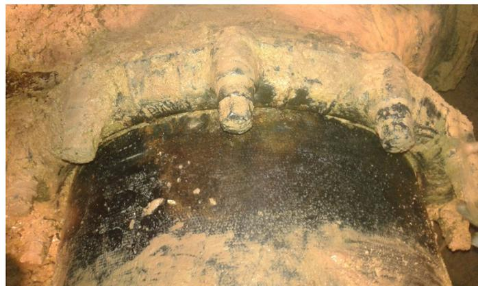
*Ilustración 48. Tornillos conguitos en una junta de fundición dúctil*
