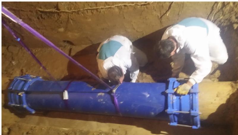
*Ilustración 60. Reparación de tubería de fibrocemento con tubería de fundición dúctil*
