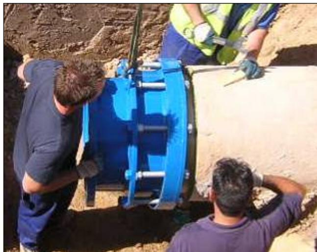
*Ilustración 89. Colocación del cabo extremo*
