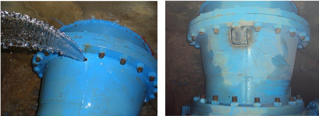
*Ilustración 47. Parche soldado para reparación de fuga tipo picadura*
