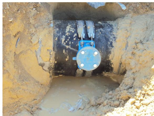
*Ilustración 46. Banda collarín en una fuga de una tubería de fundición*
