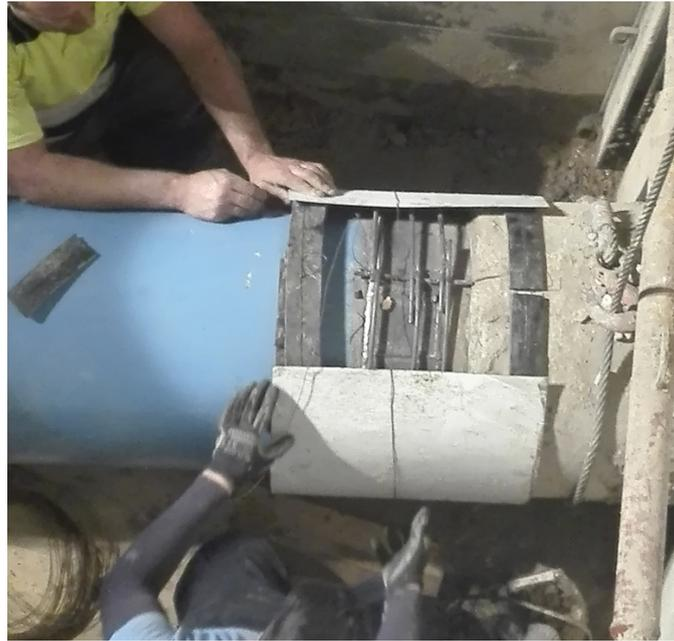
*Ilustración 87. Reconstrucción de la unión mediante mortero de reparación autonivelante*
