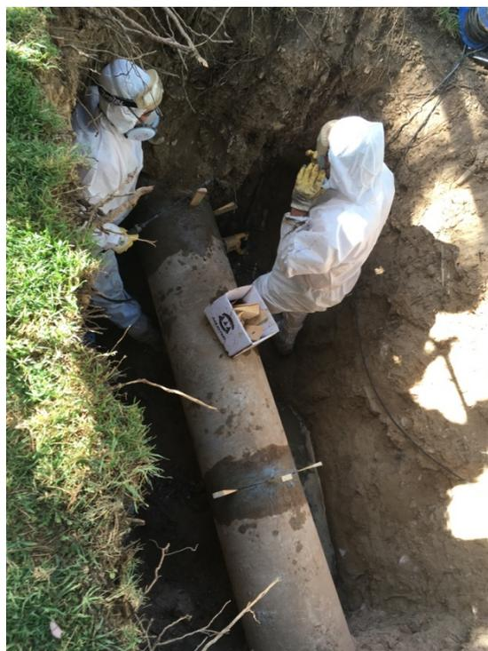
Ilustración 68. Producto químico aportado al corte de la tubería de fibrocemento para evitar la dispersión del polvo de amianto
