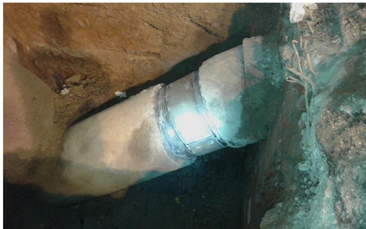
*Ilustración 74. Plancha de acero soldada a la chapa de una tubería de hormigón con camisa de chapa*
