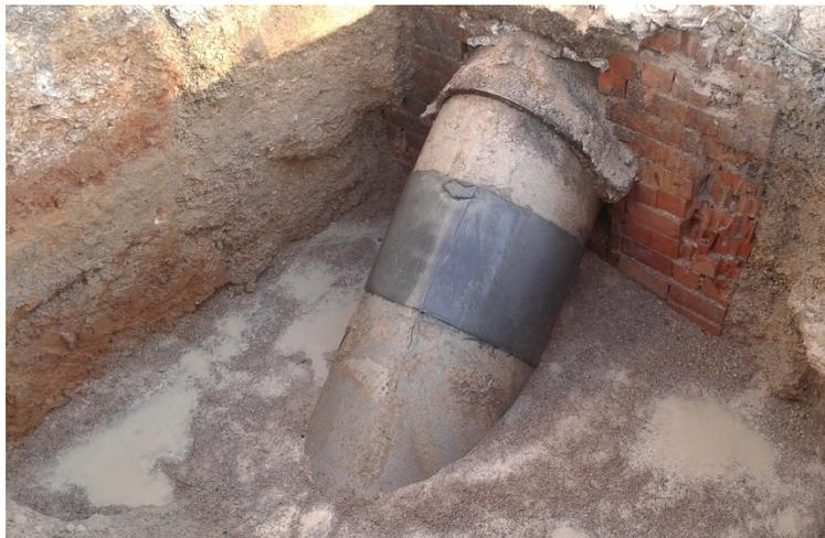
*Ilustración 76. Reparación del hormigón de recubrimiento con mortero de reparación*
