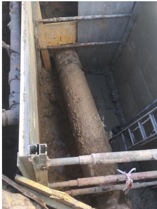
*Ilustración 80. Descubrimiento de la tubería tan por encima como por debajo*
