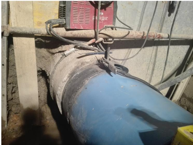
*Ilustración 86. Resultado de la soldadura con virola*
