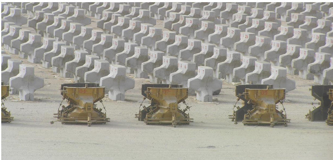
Figura 7. 66. Encofrado del Acrópodo.
