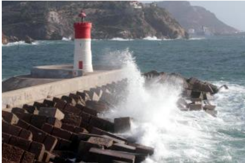
Figura 4. 12. Rebase sobre una estructura real.
