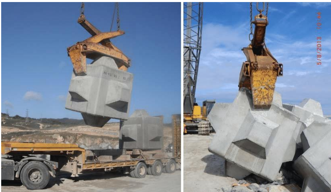
Figura 2. 12. Manipulación del Cubipodo en el parque y colocación en el manto del dique en talud mediante pinzas simples.
