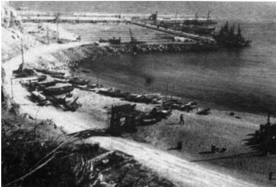
Figura 7. 4. Obras del puerto de Blanes (1932).
