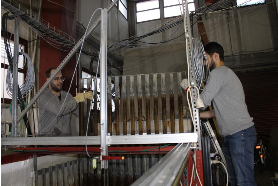
Figura 5. 17. Colocación del sistema disipador de energía.
