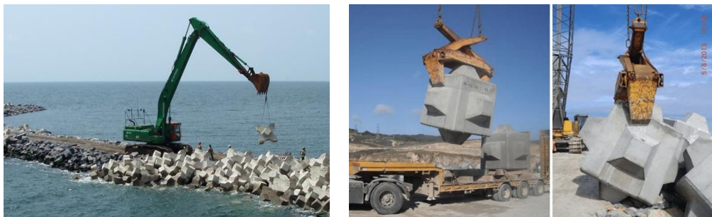
Figura 2. 1. Ejemplos de colocación con eslingas (Xbloc) y con pinzas (Cubípedo).
