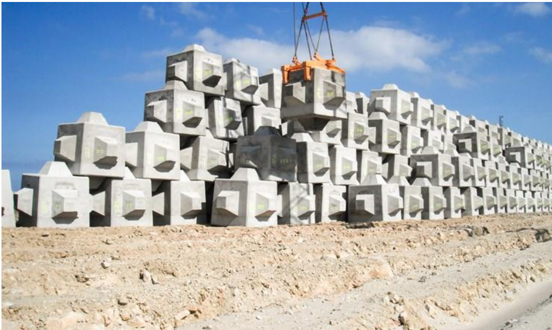
Figura 2. 13. Disposición en almacenamiento abierto.
