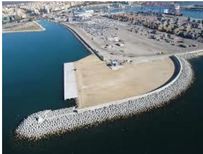
Figura 0. 1. Dique en talud de Cubipodos de Málaga.
