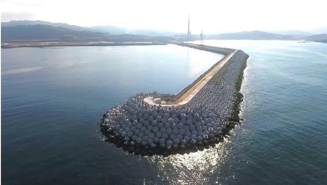
Figura 2. 5. Dique en talud real con manto principal de Cubípodos en A Coruña.
