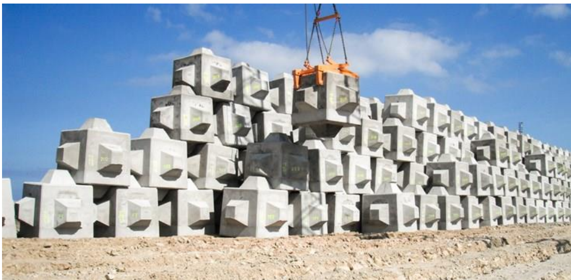
Figura 7. 68. Acopio de Cubípodos.
