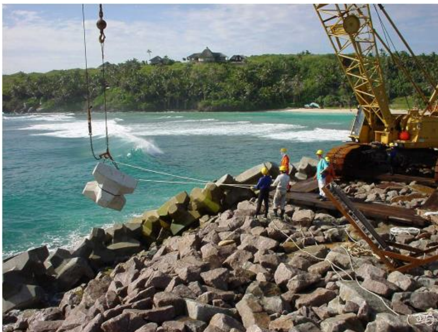
Figura 7. 67. Colocación del Acrópodo mediante eslingas.
