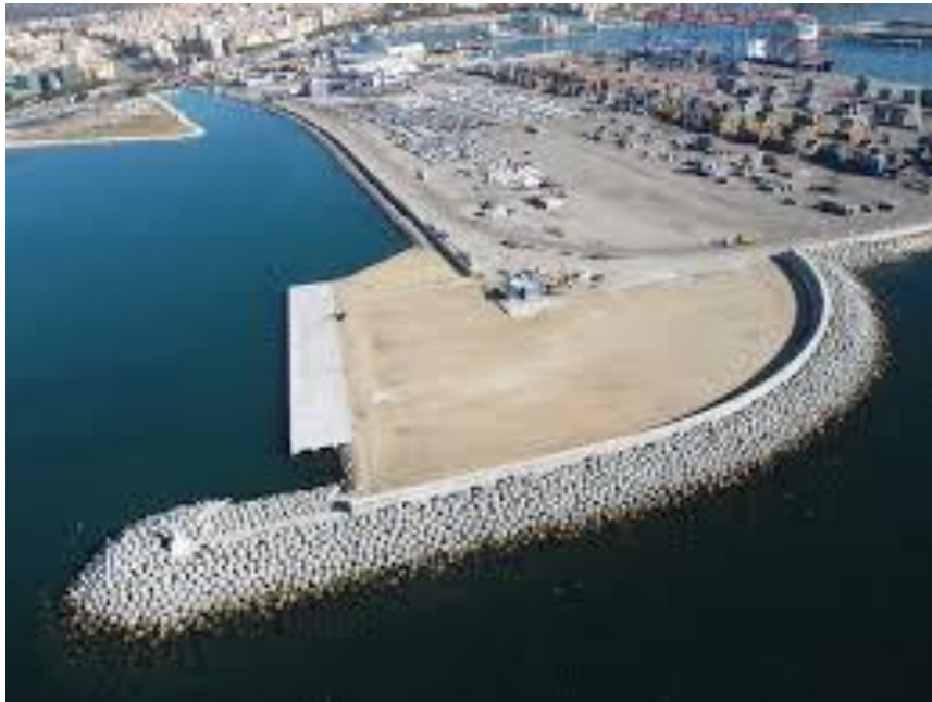
Figura 2. 15. Dique en talud con manto de Cubípodos (Málaga).
