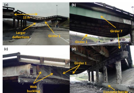
Fig. 6. Puente analizado en la publicación [10]. Fuente: [10].
